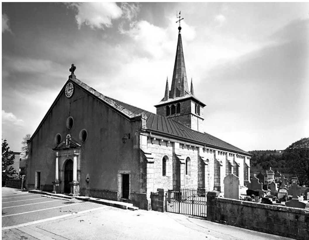
Façade antérieure et face droite.
