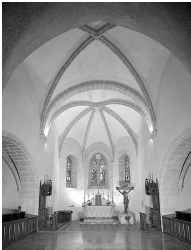
Le chœur vu depuis la nef.
