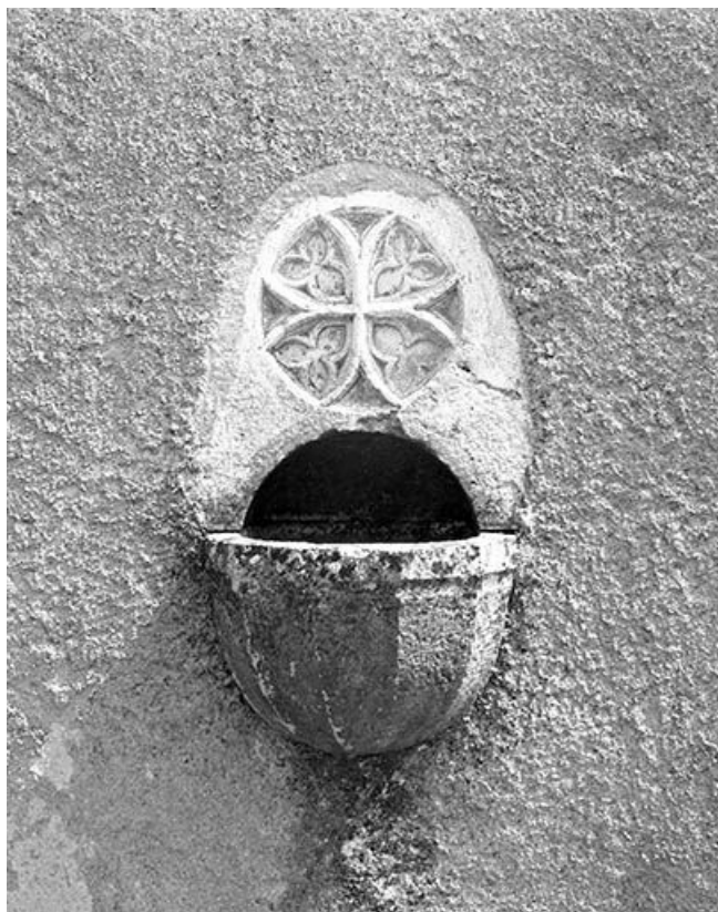
Bénitier du mur de la façade antérieure.
