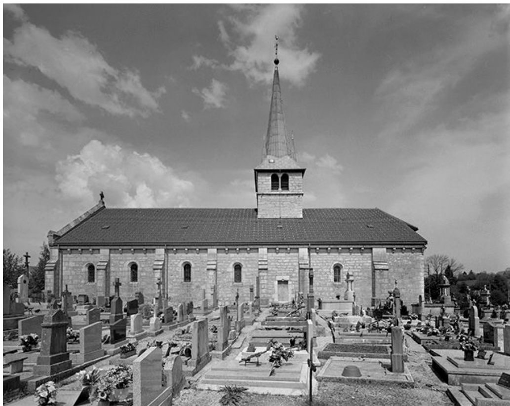
Façade latérale droite.
