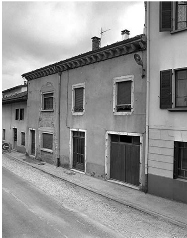
Façade antérieure d'une ferme transformée en maison. 39, Longchaumois
