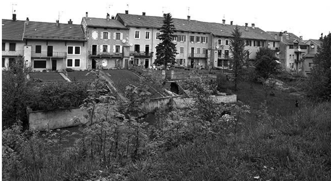
Façades postérieures des maisons et immeubles bordant la rue principale du village. 39, Longchaumois
