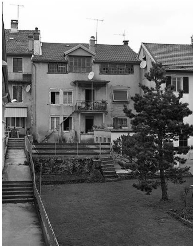
Façade postérieure d'un immeuble.
