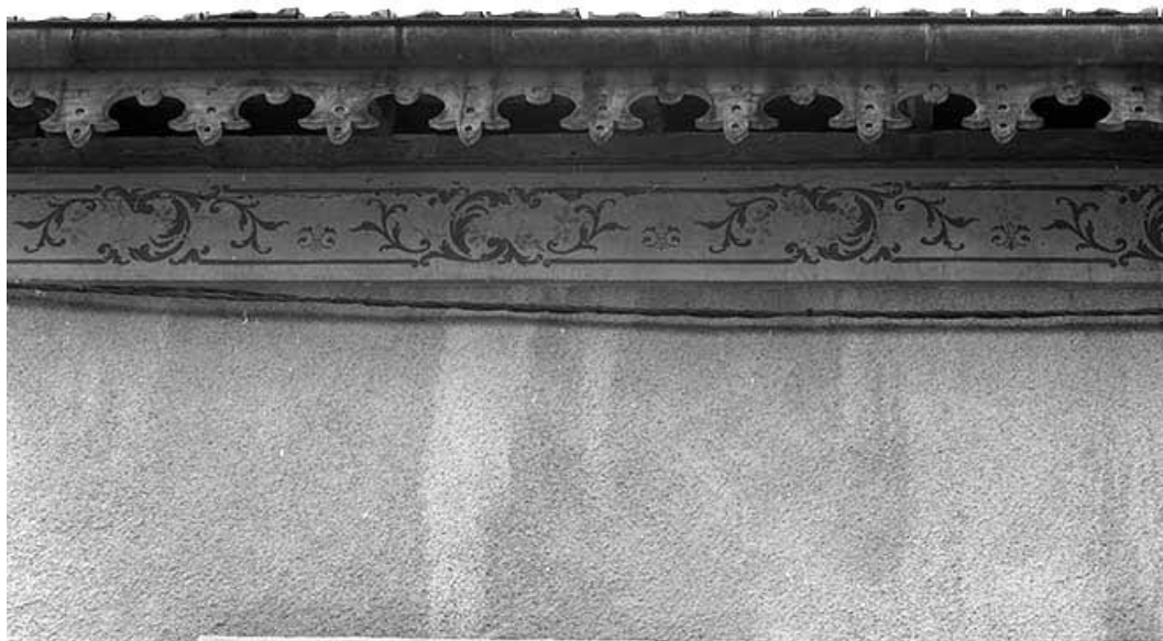
Détail d'une planche de rive et de décor de façade.
