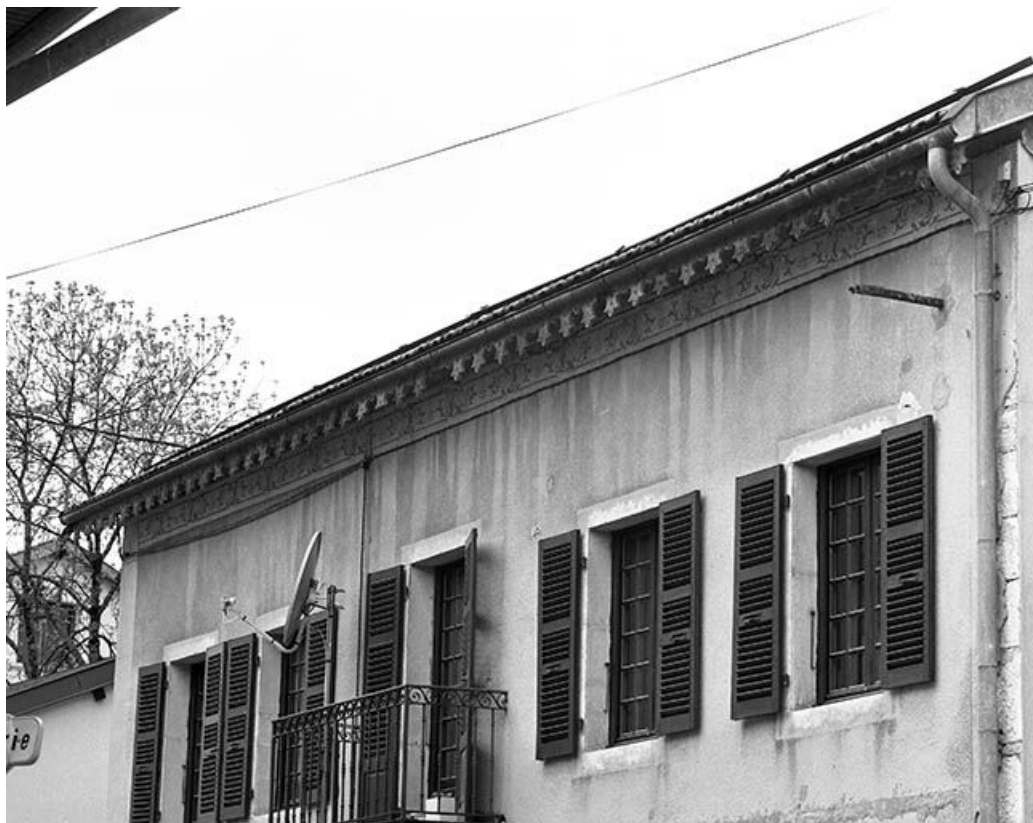
Décor en partie supérieure de la façade.
