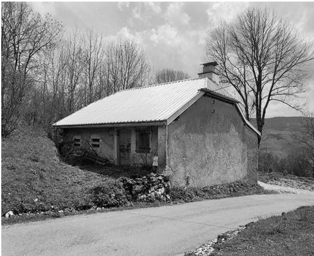
Façade antérieure et face droite.
