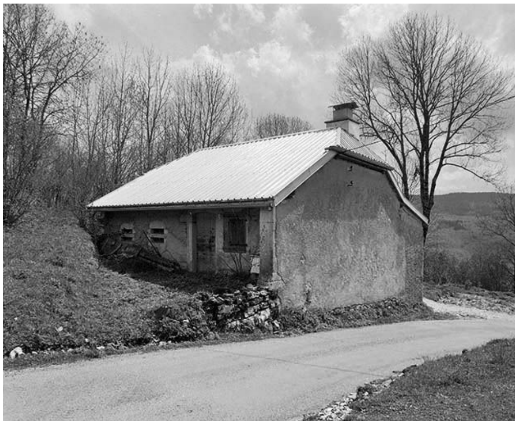
Façade antérieure et face droite.
