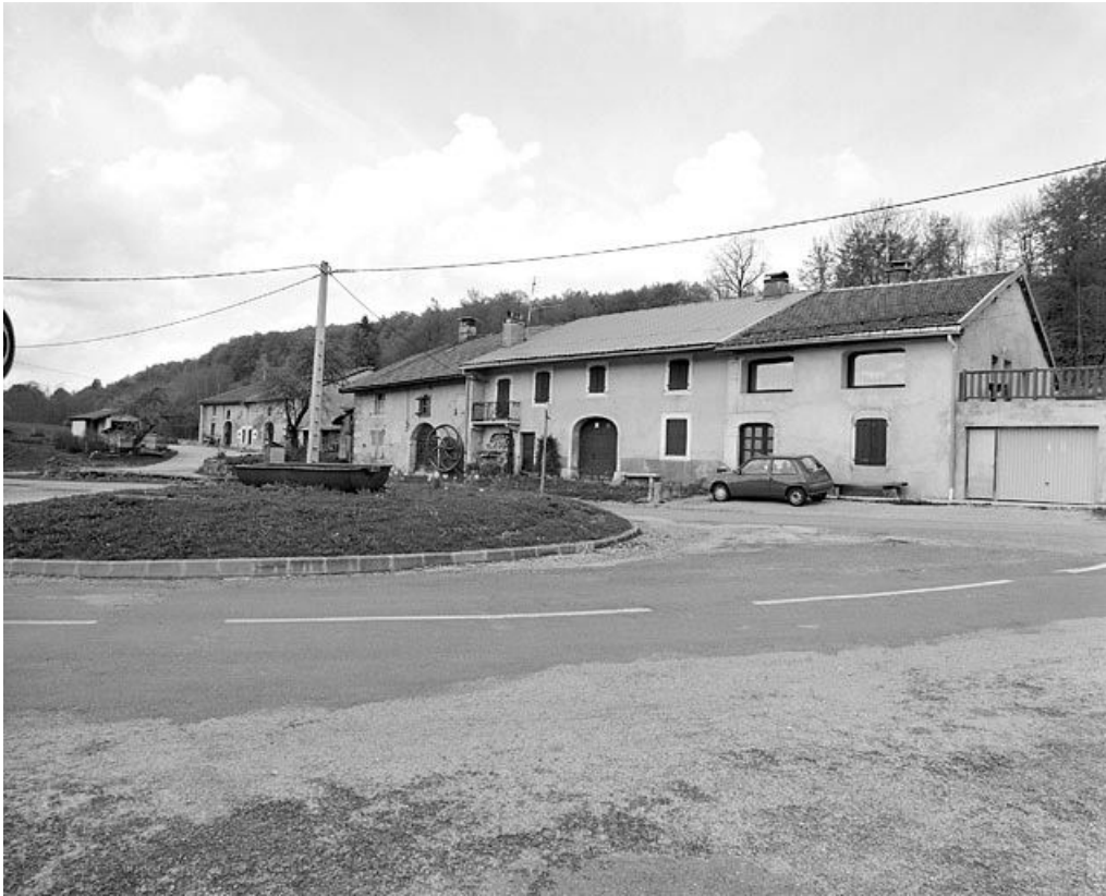
Ferme bordant le C.D. 26 traversant le village. 39, Lézat
