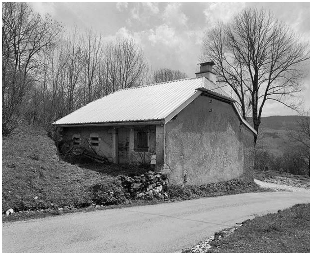
Façade antérieure et face droite.
