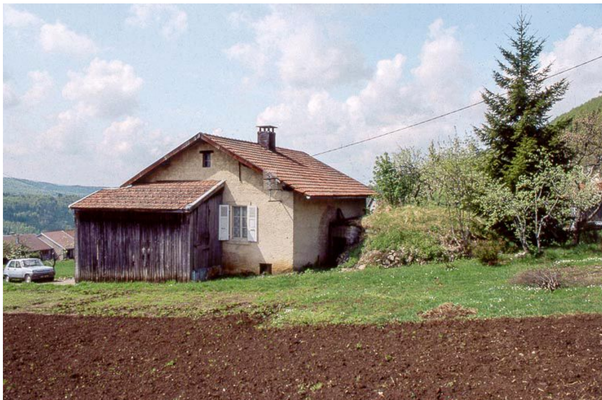
Façade postérieure et face droite.
