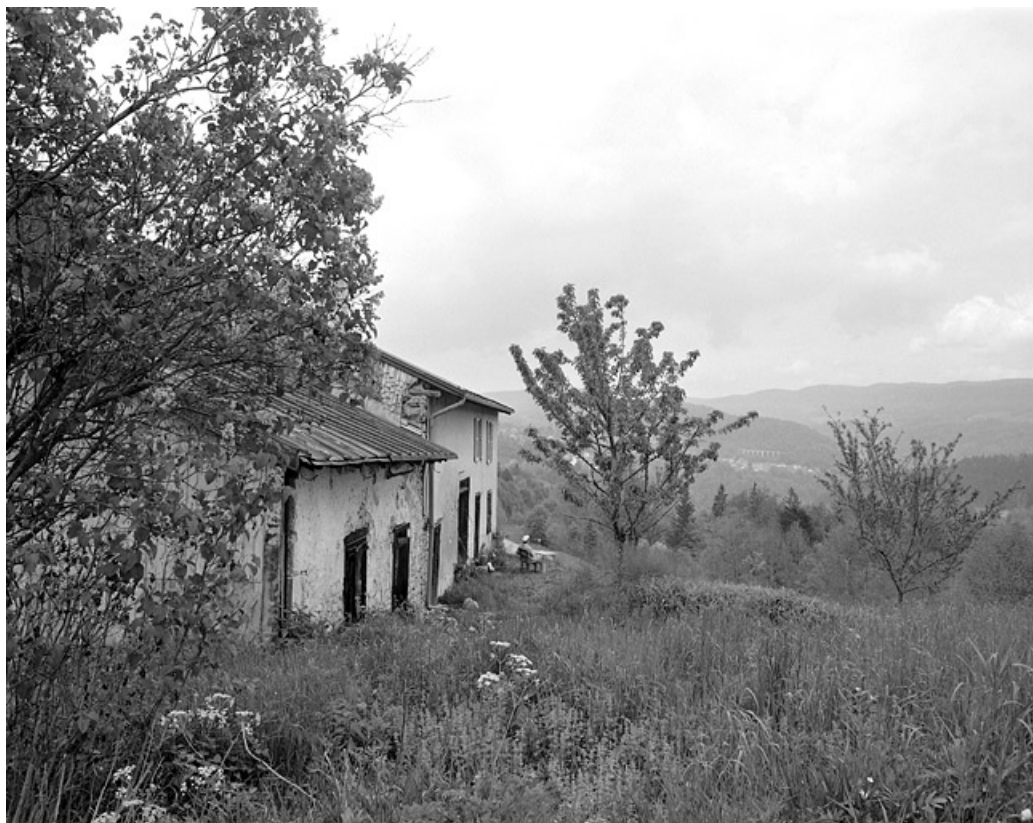
Façade antérieure vue de trois quarts. 65, Tancua
