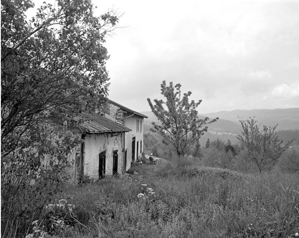
Façade antérieure vue de trois quarts. 65, Tancua
