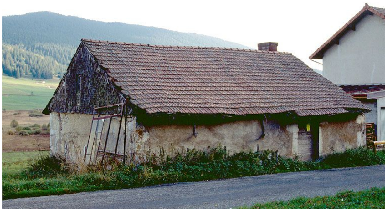
Façade antérieure et face gauche vue de trois quarts.
