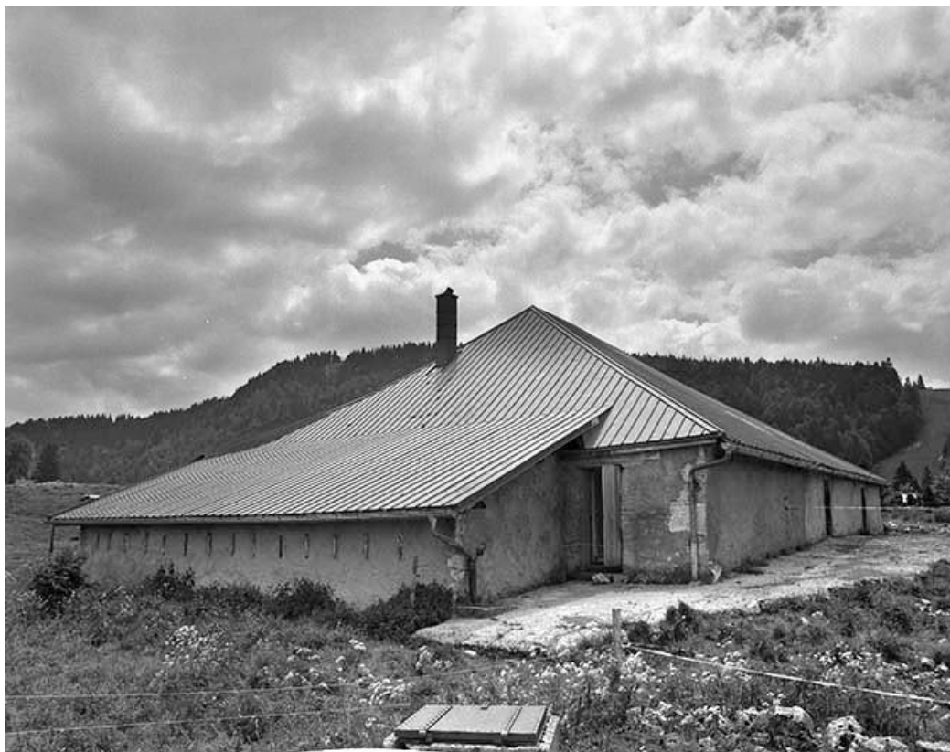
Façade postérieure vue de trois quarts gauche.
