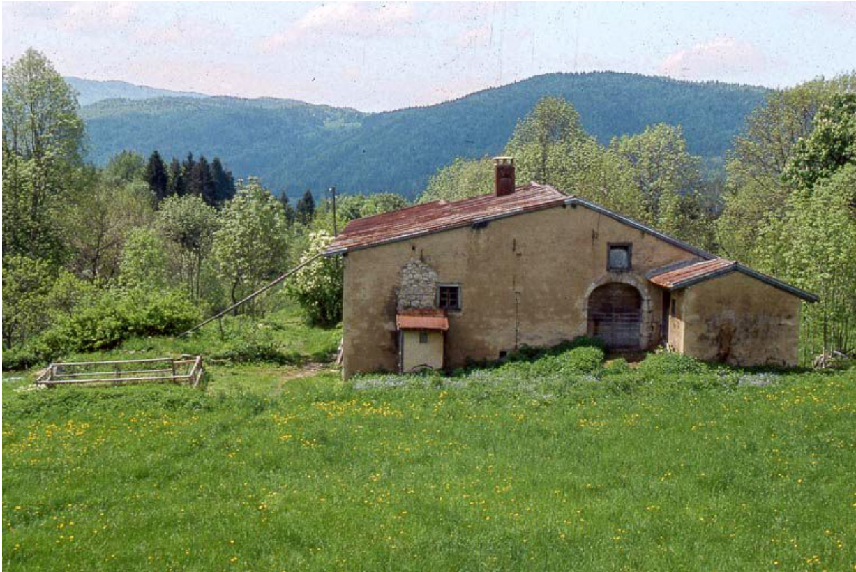
Face gauche et accès à la grange haute.
