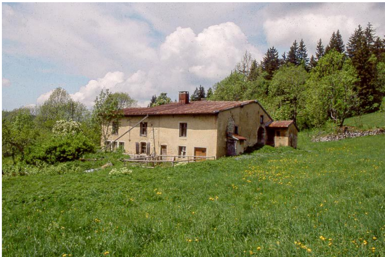
Vue éloignée de la façade antérieure.
