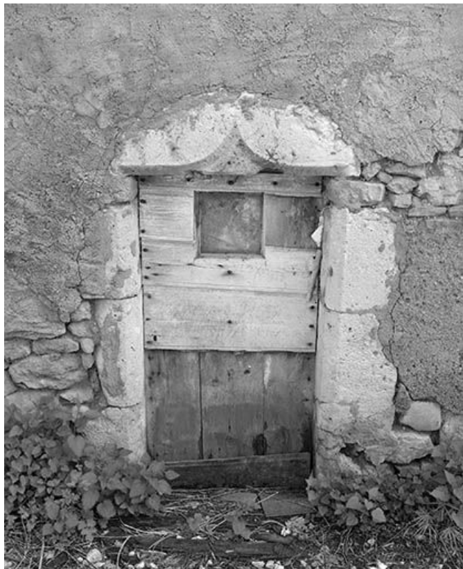
Linteau en accolade sur la façade postérieure.
