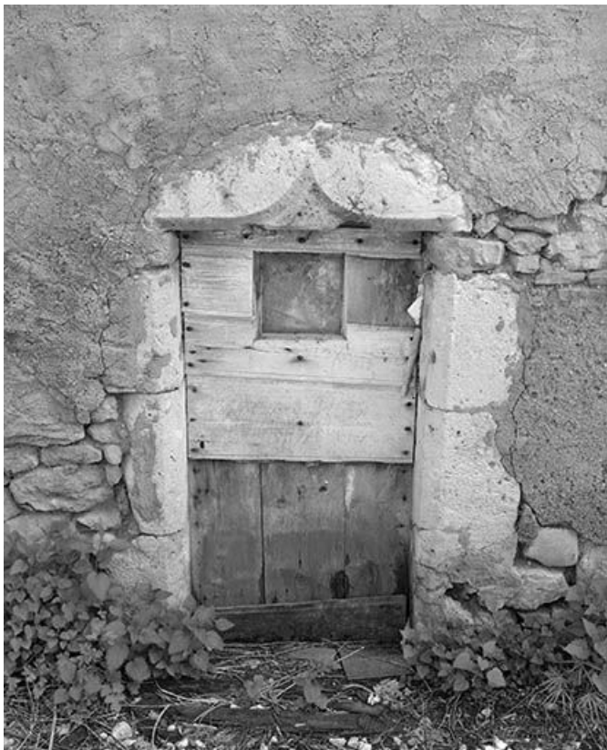
Linéau en accolade sur la façade postérieure.
