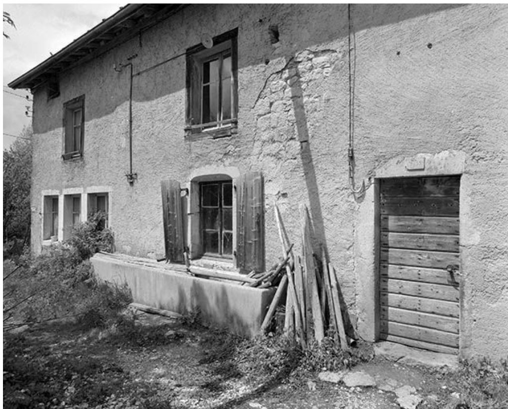
Façade antérieure, vue vers l'atelier dans le prolongement du logis.
