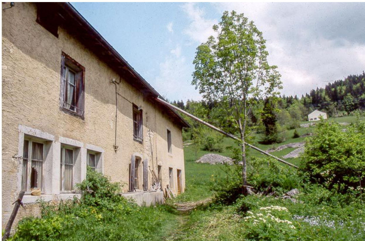
Façade antérieure de trois quarts, descente d'eau vers la citerne.
