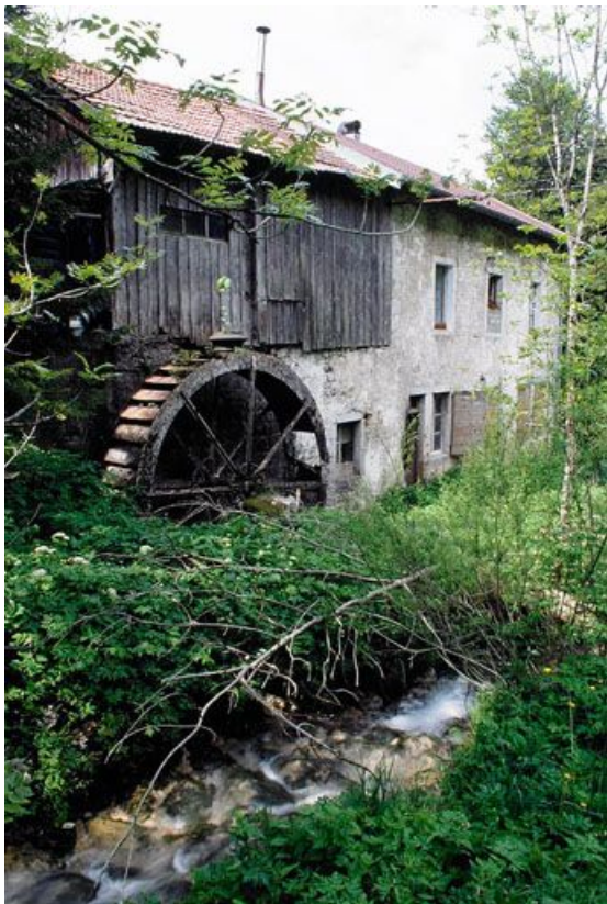
Façade postérieure, roue et bief Bruyant.
