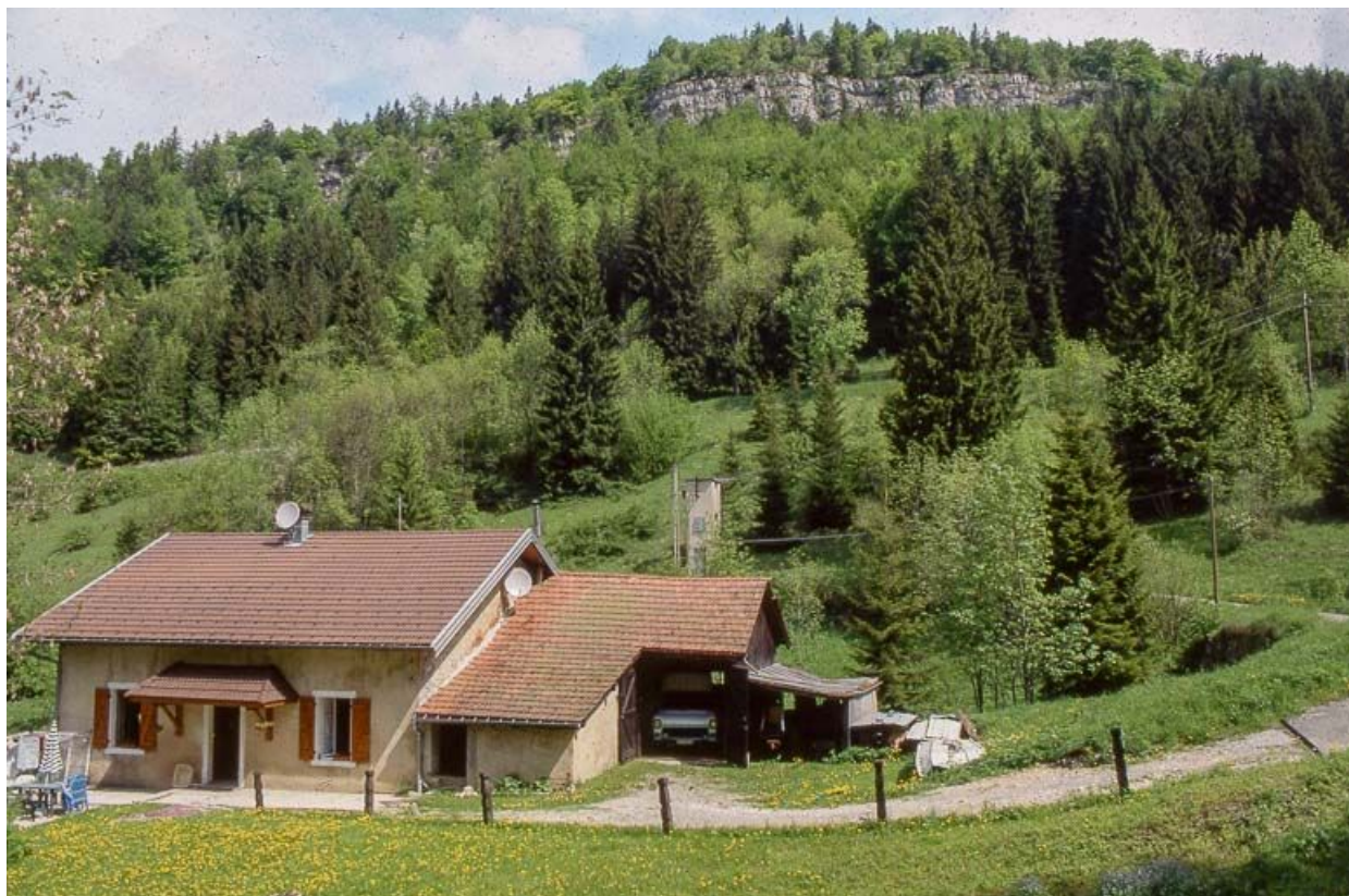
Vue éloignée du bâtiment dans le site, façade antérieure.
