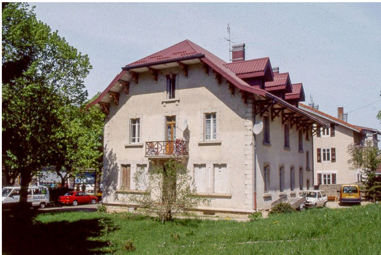
Façade postérieure et face droite vues de trois quarts.
