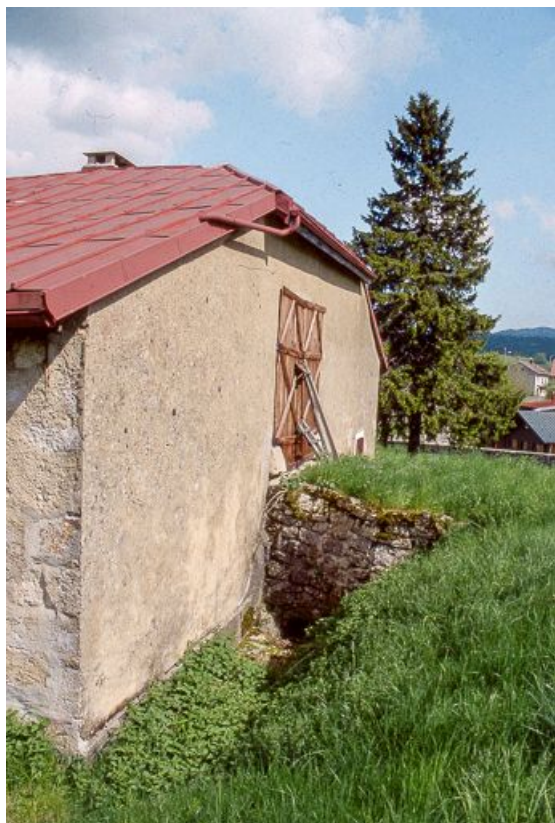
Face gauche et levée de grange.
