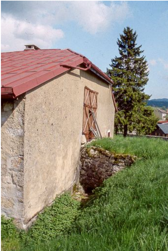
Face gauche et levée de grange.
