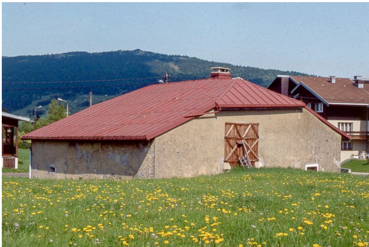
Façade postérieure et face latérale gauche vues de trois quarts.
