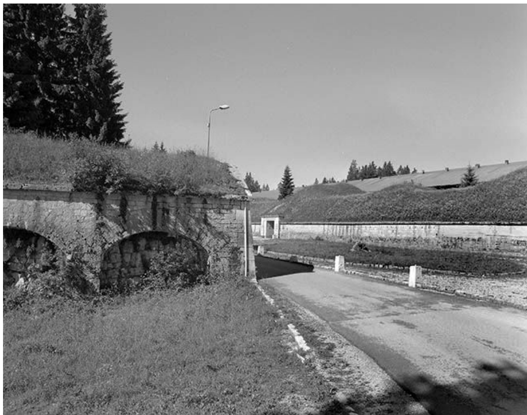
Voie d'accès au fort et fortifications avancées.
