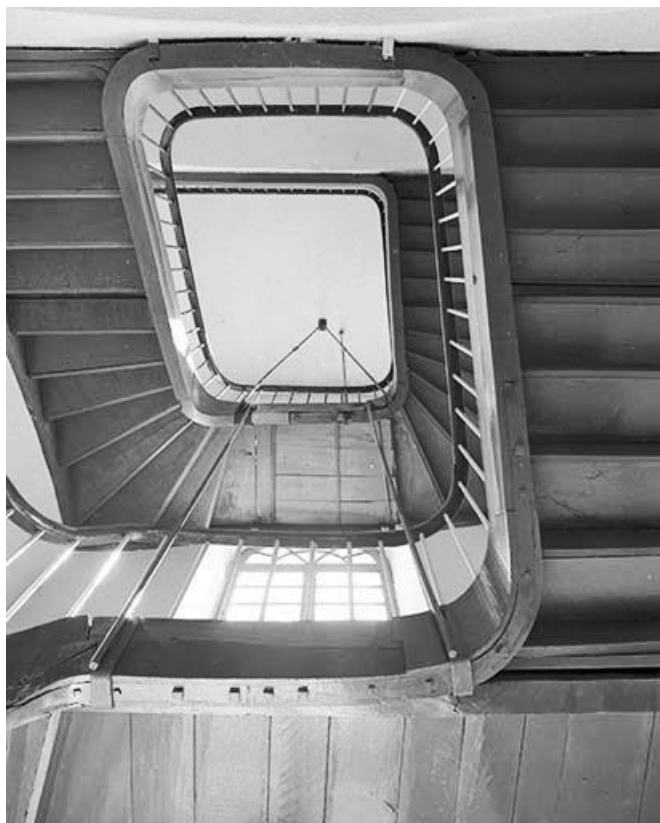
Bâtiment Quitry, escalier intérieur.
