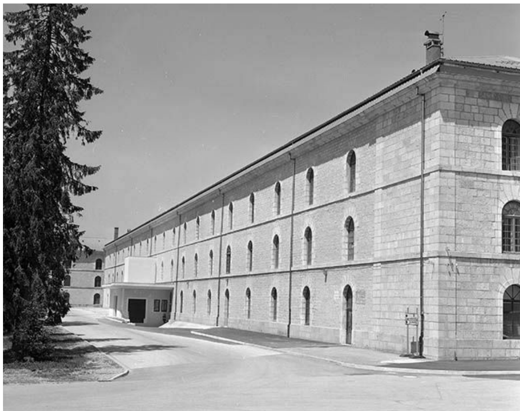
Bâtiment Quitry, façade sur la cour d'exercice.
