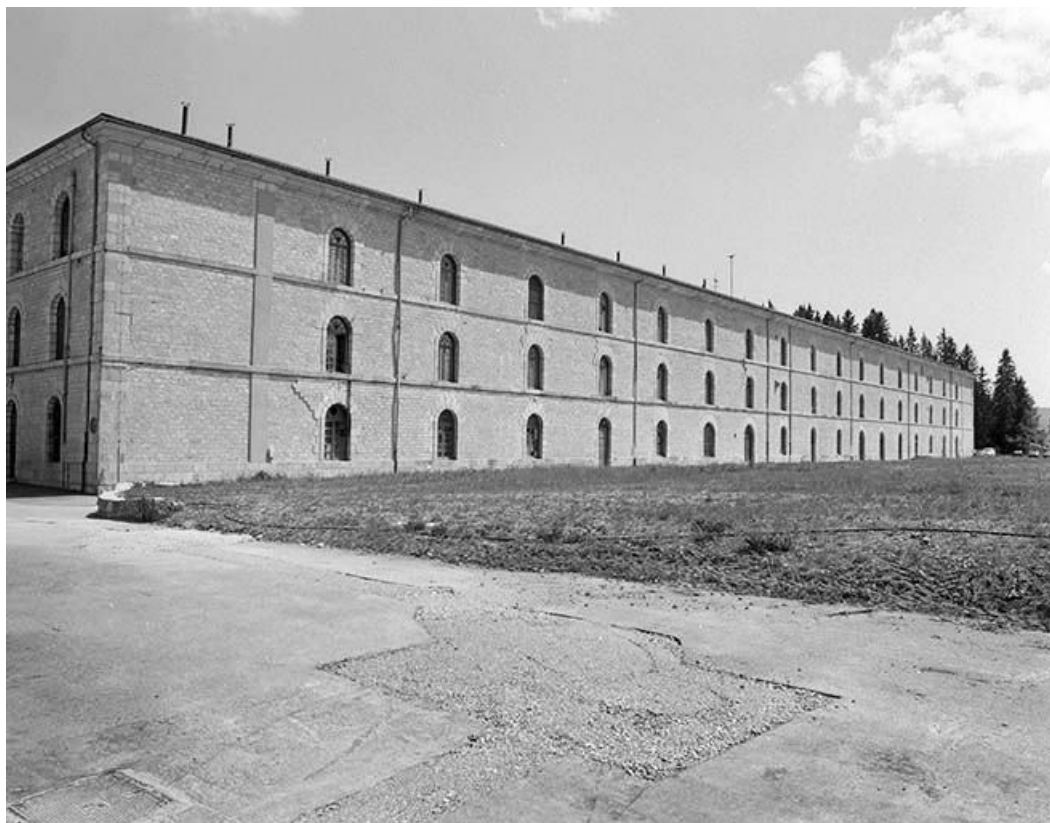
Bâtiment Saint-Germain, façade postérieure.
