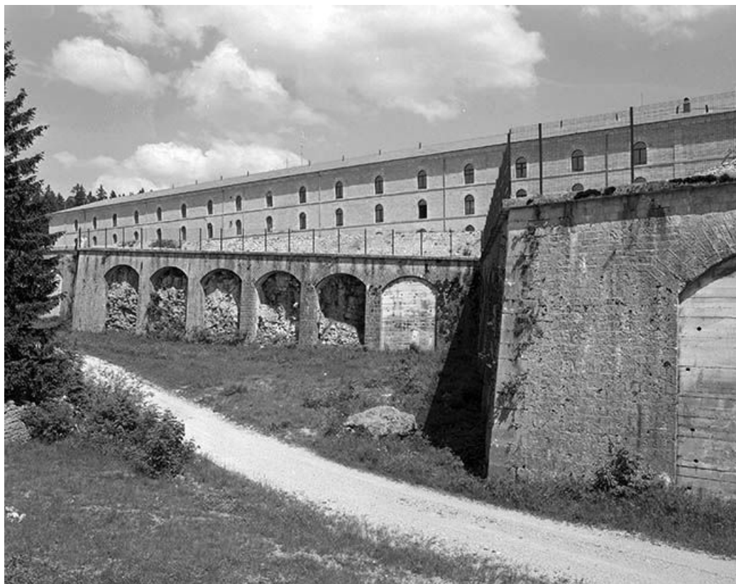
Enceinte du fort, système bastionné.
