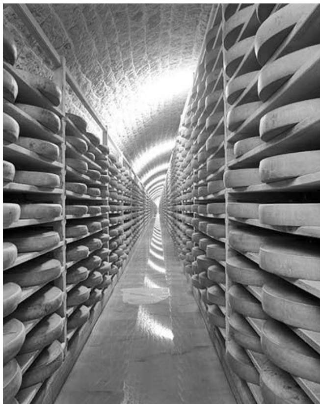
Bâtiment Cavalier, pièce d'affinage aménagée.
