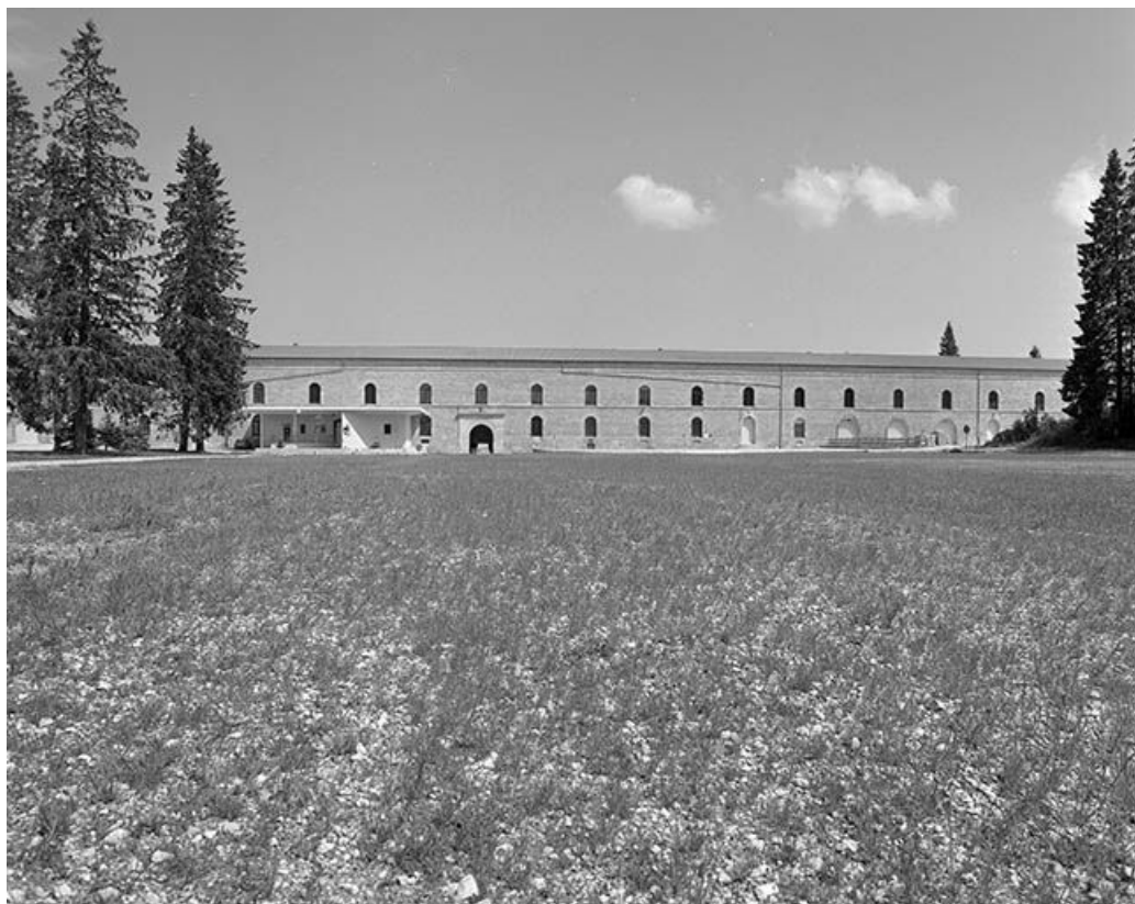
Bâtiment Cavalier, façade sur la cour d'exercice.
