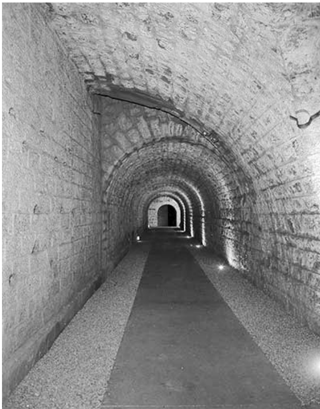
Galerie de circulation à l'intérieur du fort.
