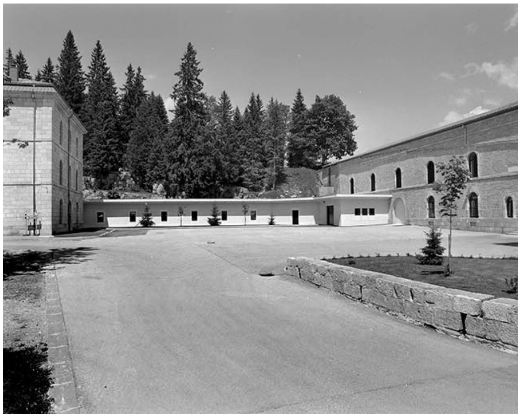
Aménagements récents reliant le bâtiment Quitry au bâtiment Cavalier.
