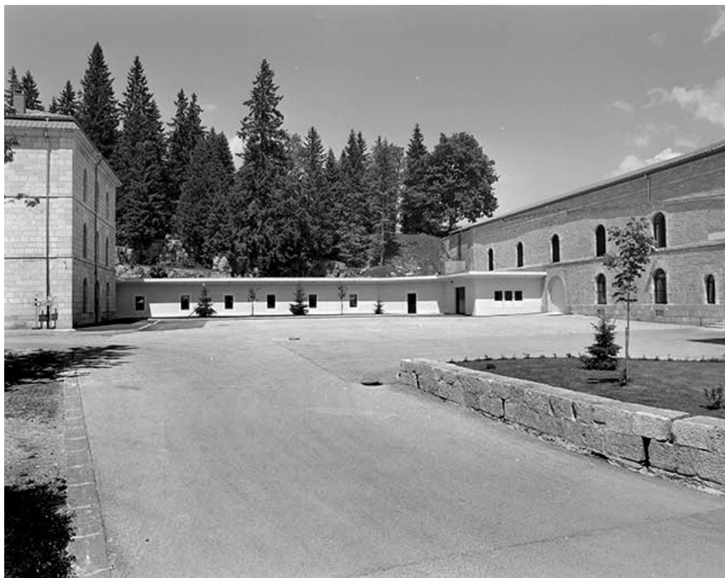
Aménagements récents reliant le bâtiment Quitry au bâtiment Cavalier.
