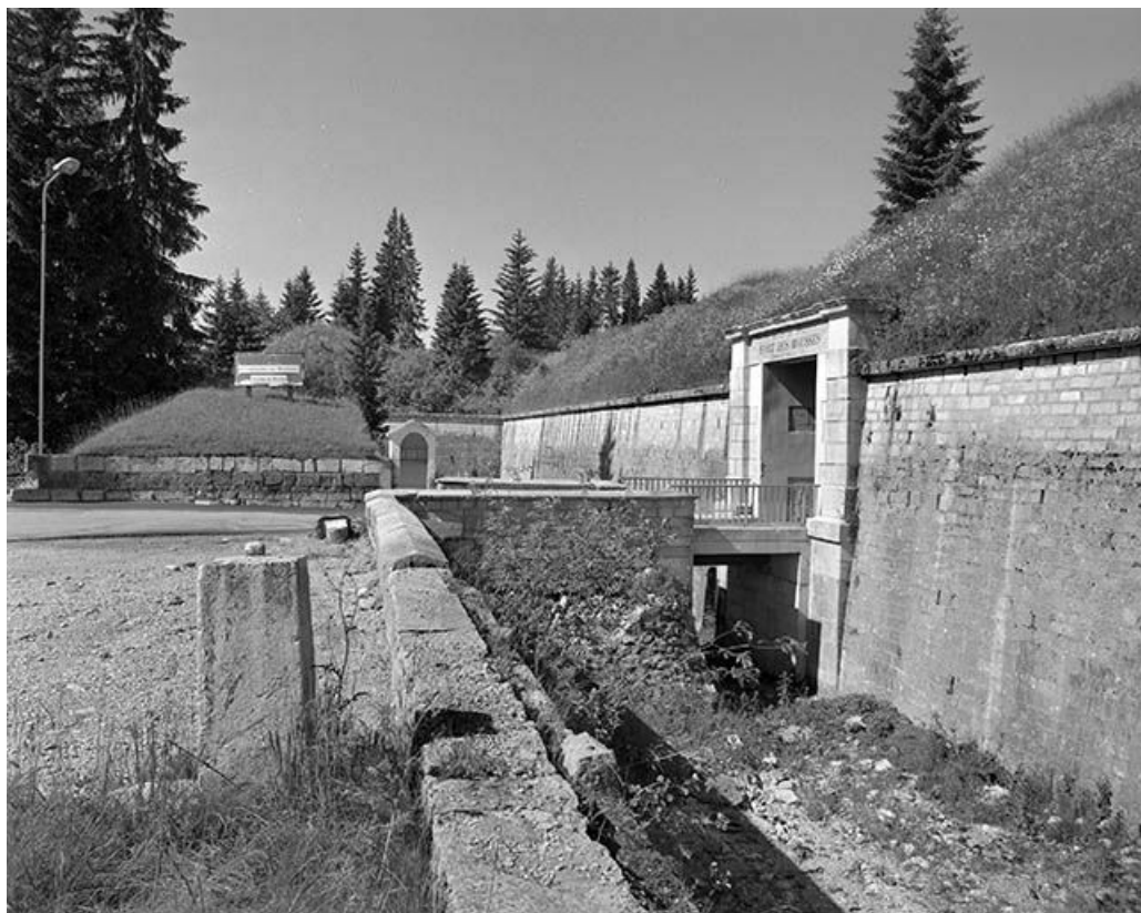
Porche d'accès au fort, fossé.
