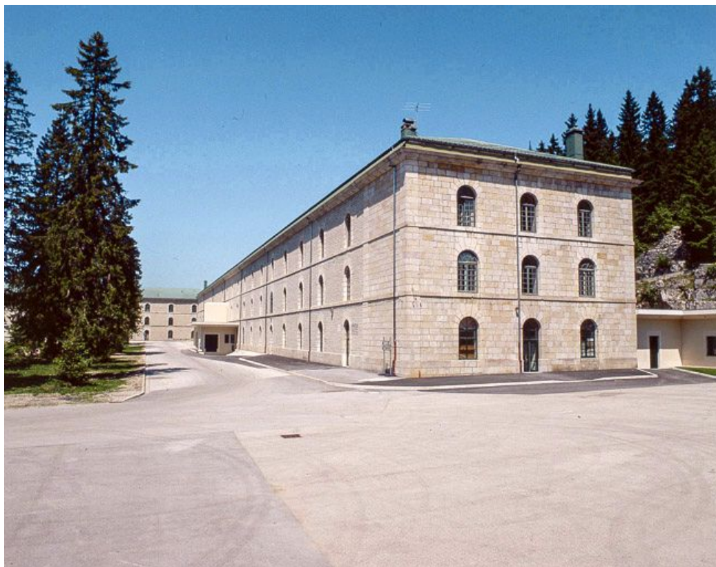
Bâtiment Quitry, façade antérieure et face droite.
