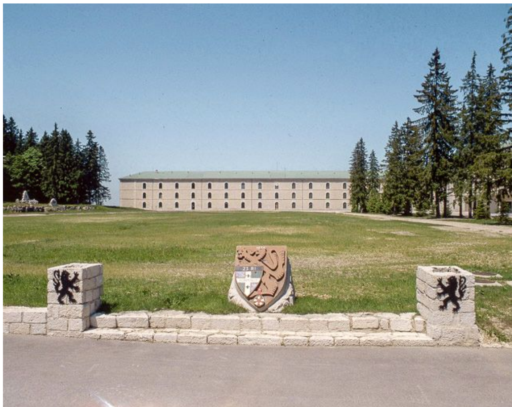
Bâtiment Saint-Germain, vue éloignée de la façade antérieure sur la cour d'exercice. 39, Les Rousses R.N. 5
