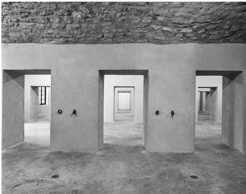
Bâtiment Quitry, pièces successives couvertes de voûtes en berceau segmentaire. 39, Les Rousses R.N. 5
