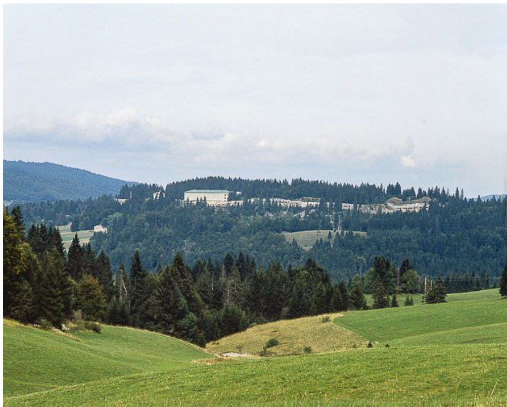
Vue du fort depuis Prémamanon.
