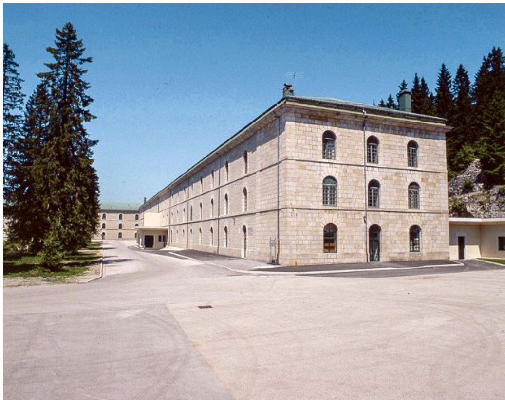
Bâtiment Quitry, façade antérieure et face droite.
