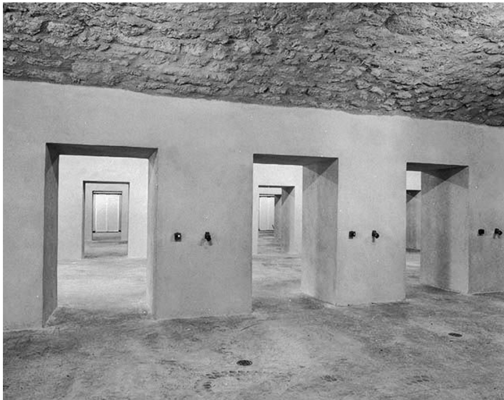
Bâtiment Cavalier, salles successives couvertes de voûtes en berceau segmentaire.
