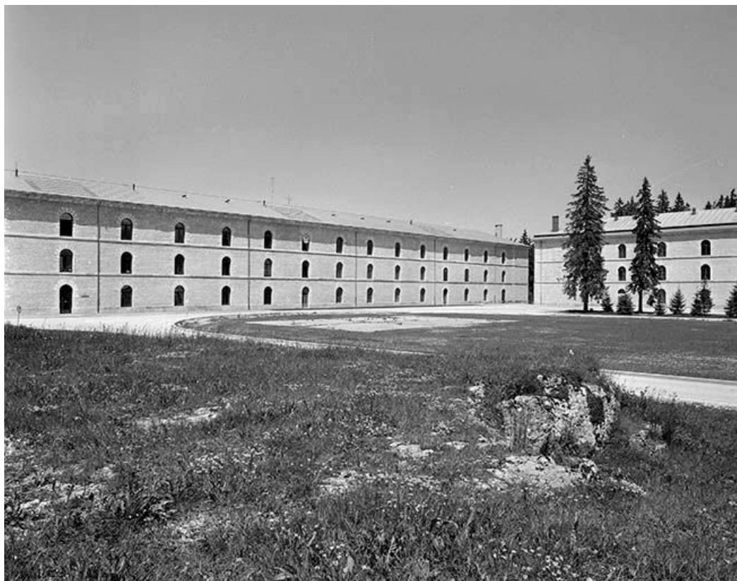
Bâtiment Saint-Germain, façade antérieure.
