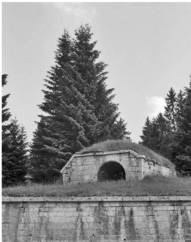
Ouvrage avancé face au porche d'accès.
