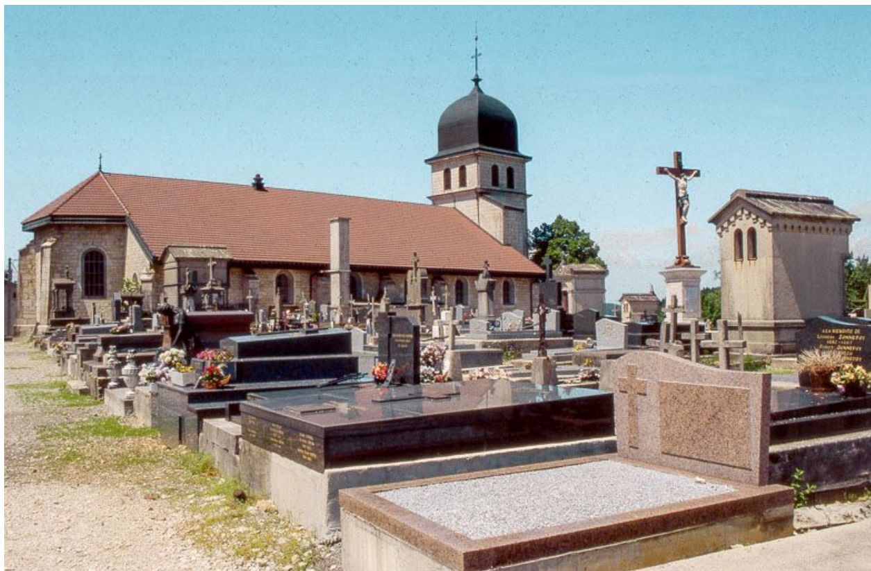
Façade latérale gauche, et au premier plan le cimetière.
