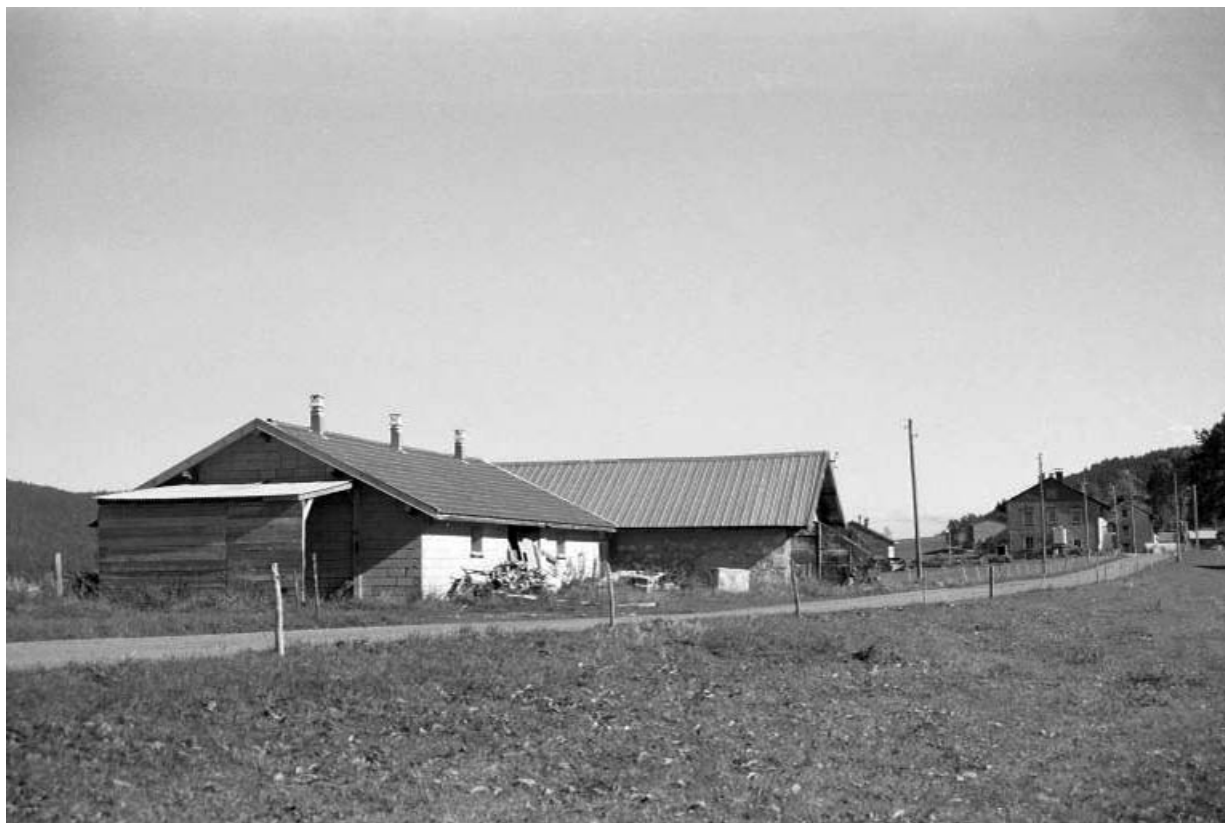
Vue d'ensemble, depuis le sud. Porcherie au premier plan.
