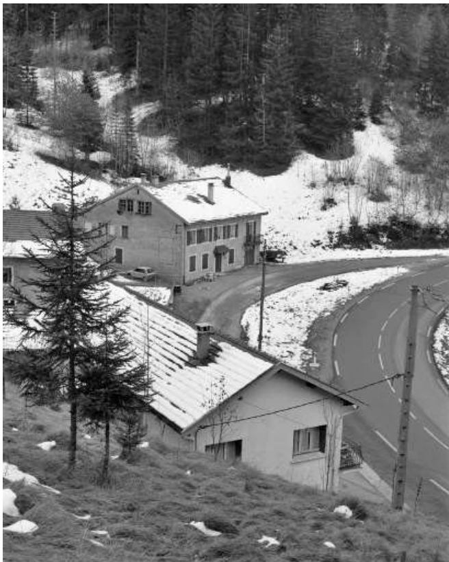
Vue d'ensemble plongeante, depuis le nord.
