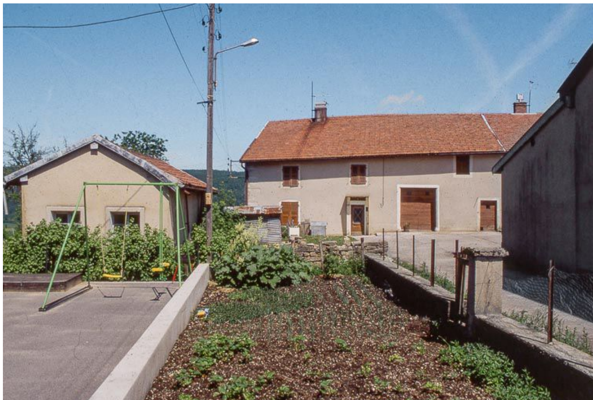
Vue éloignée de la façade antérieure.
