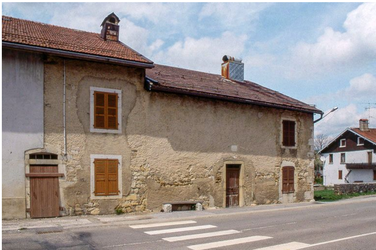
Façade antérieure vue de trois quarts gauche.
