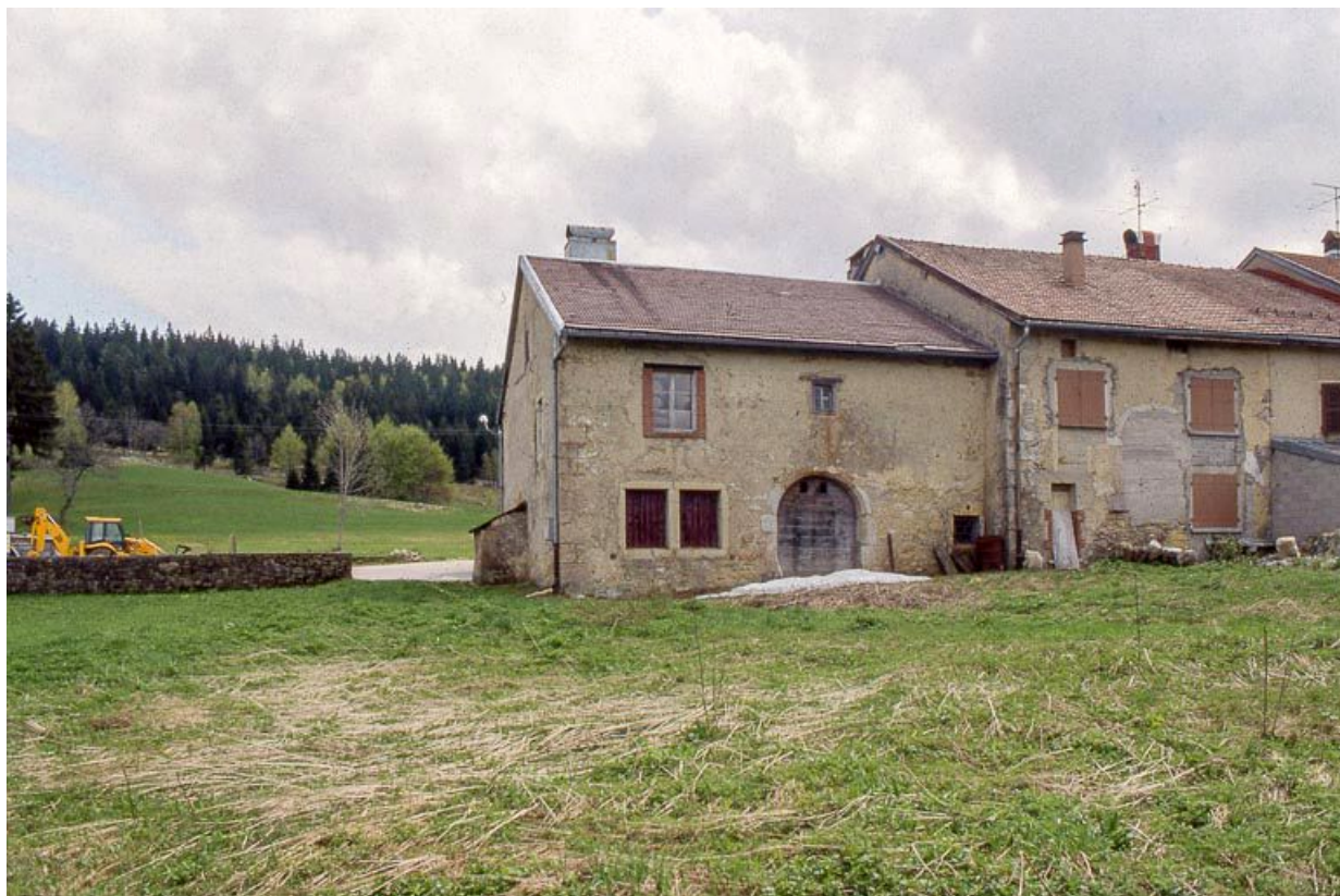
Vue éloignée de la façade postérieure.
