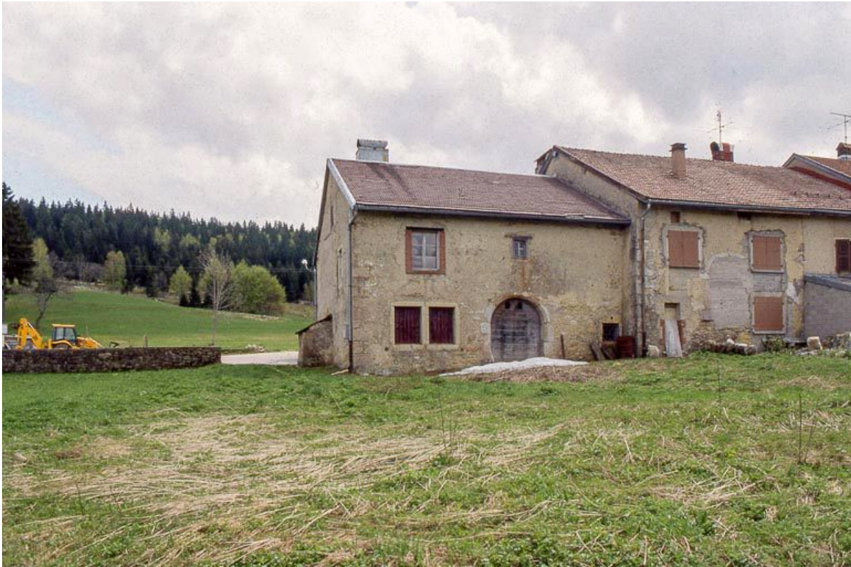
Vue éloignée de la façade postérieure.
