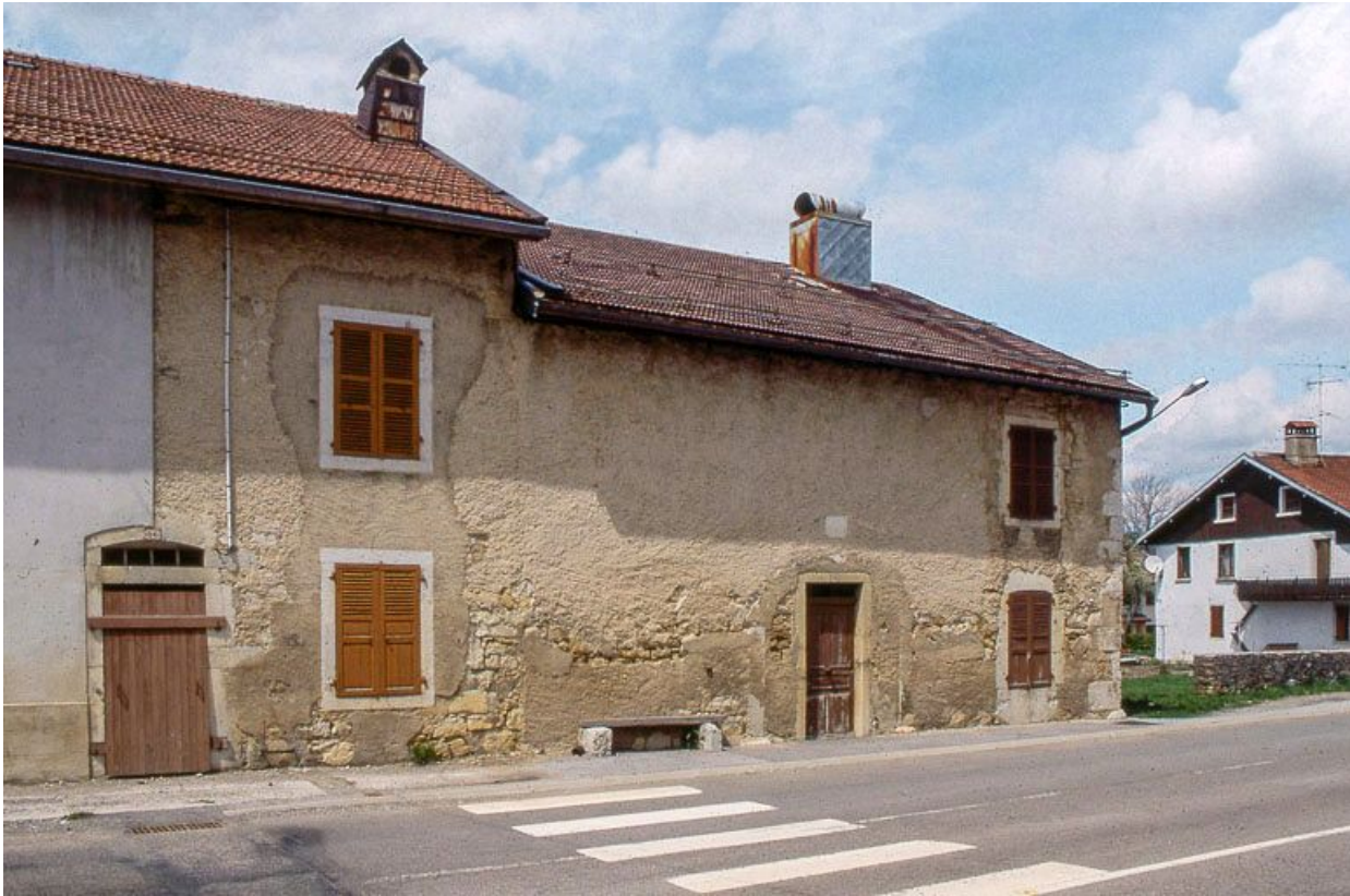
Façade antérieure vue de trois quarts gauche. 39, La Mouille
