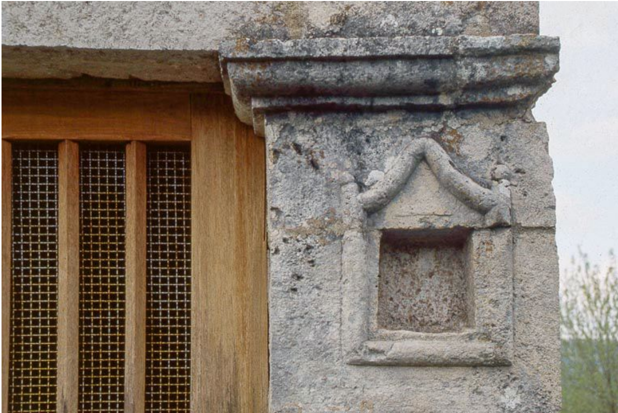
La niche du piédroit de la porte.
