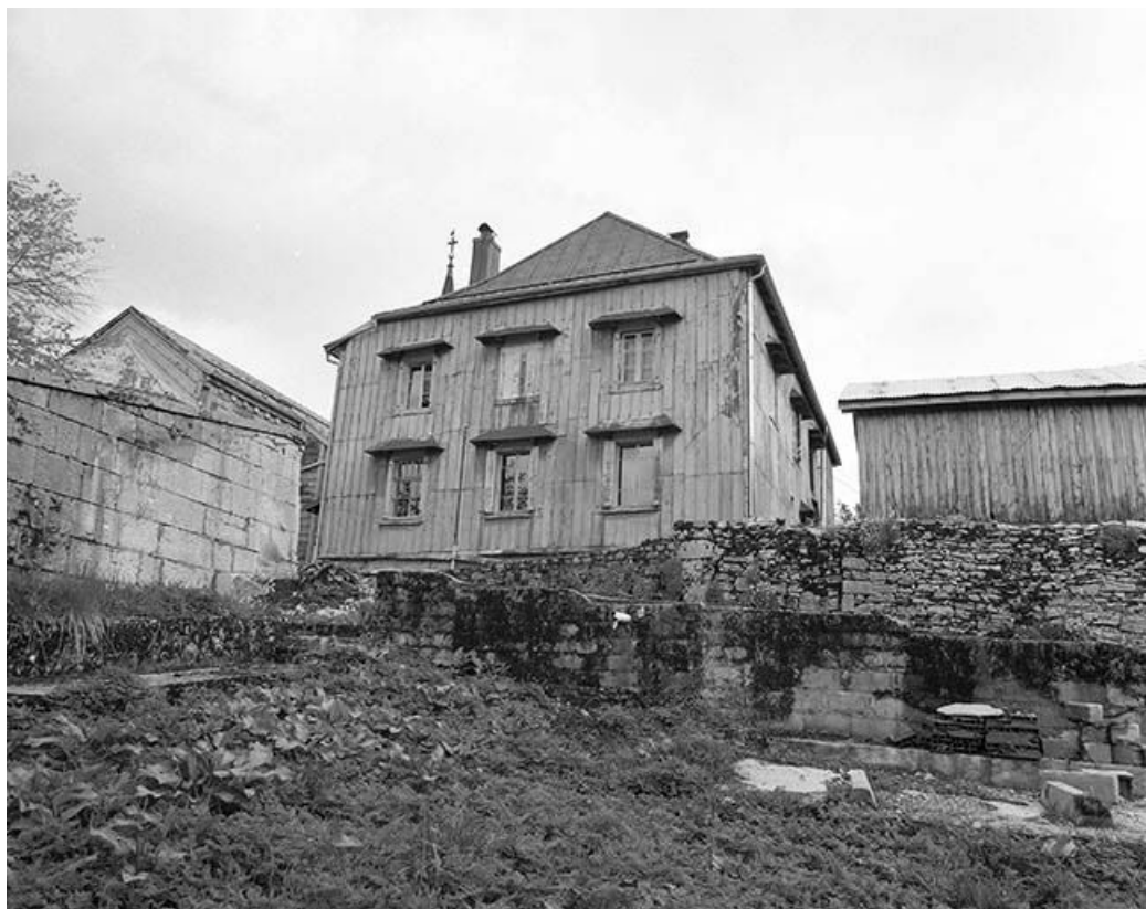
Vue éloignée de la façade ouest.
