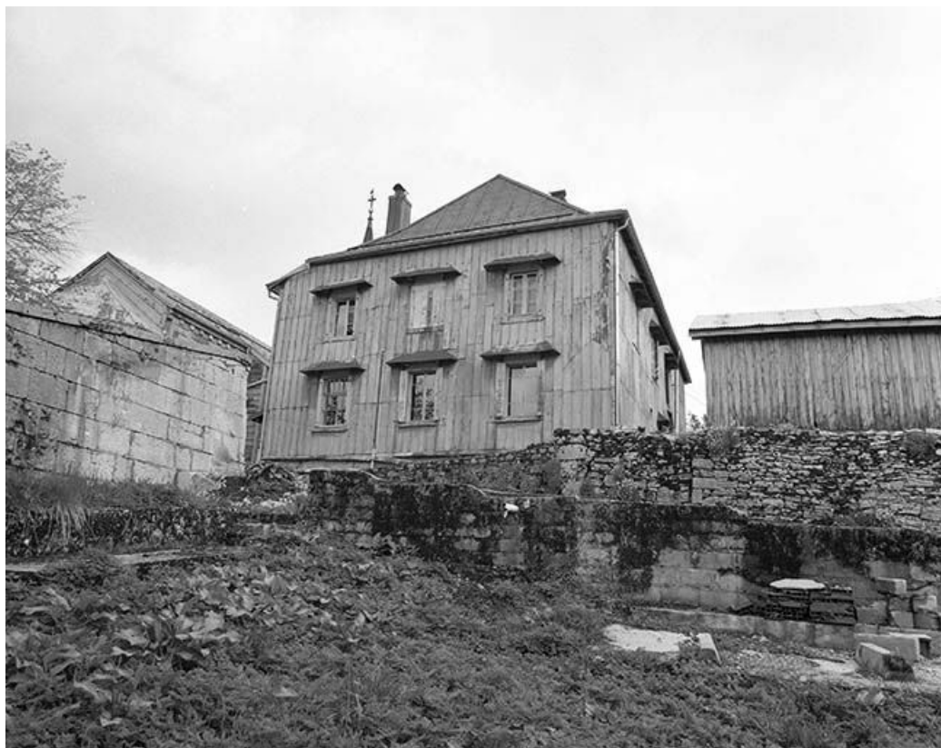
Vue éloignée de la façade ouest.
