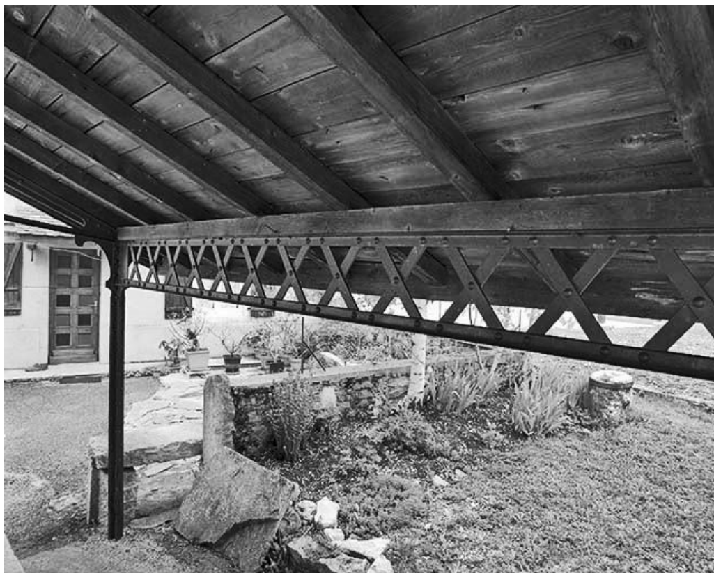
Détail de la panne sablière.
