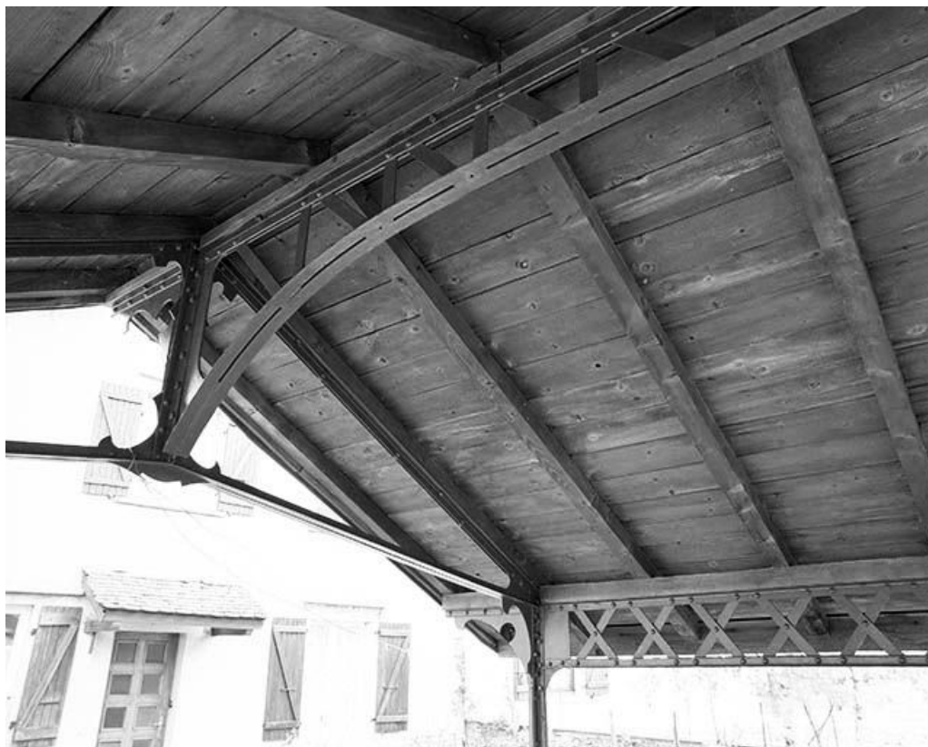
Charpente métallique : faitage et sablière. 39, La Mouille
