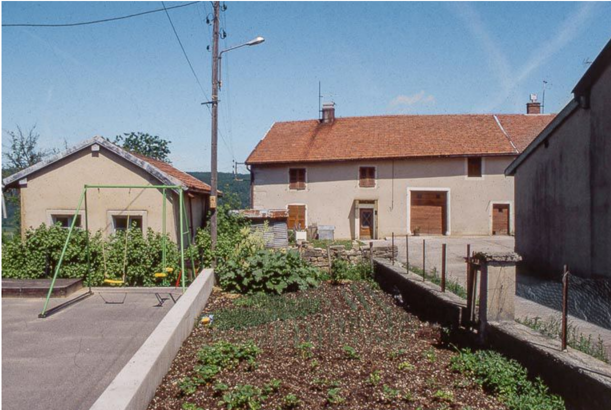
Vue éloignée de la façade antérieure.
