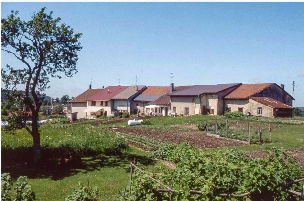
Façade postérieure des fermes du hameau du Bourgeat d'Amont. 39, La Mouille
