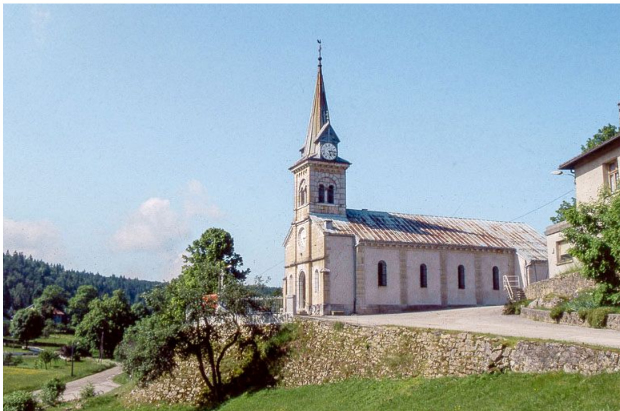
Façade antérieure et face droite.
