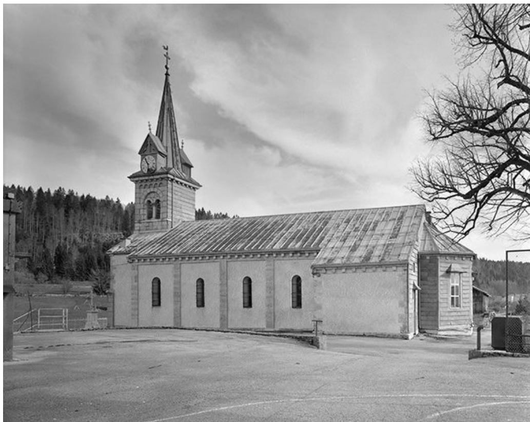
Façade latérale droite.
