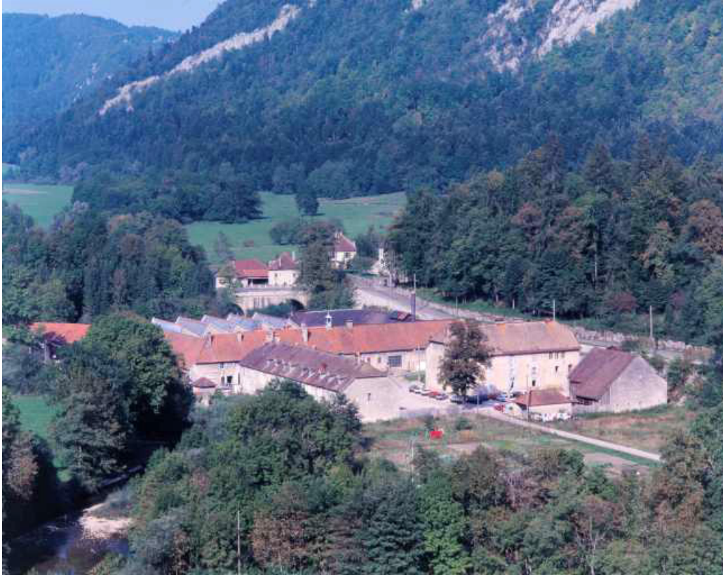
Vue d'ensemble du site depuis le sud-ouest.
