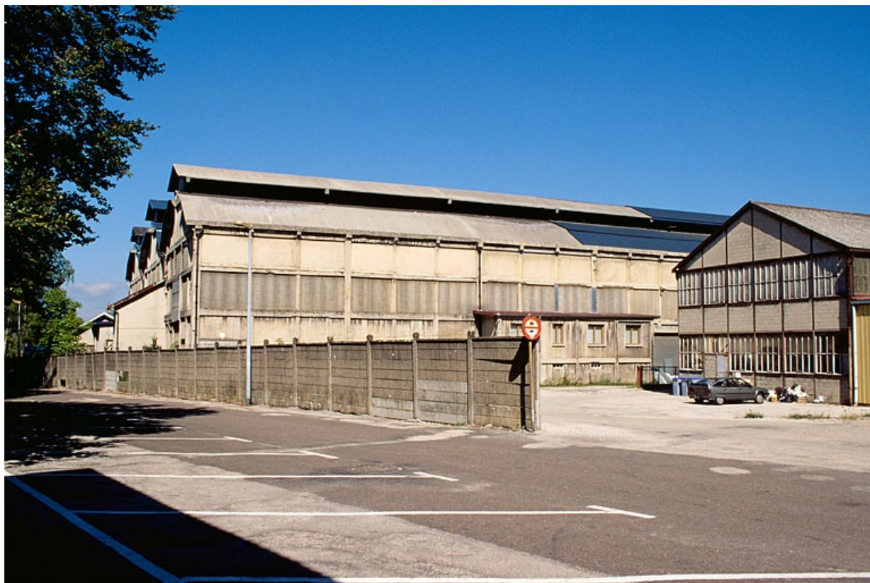
L'ancienne fonderie depuis le sud.
