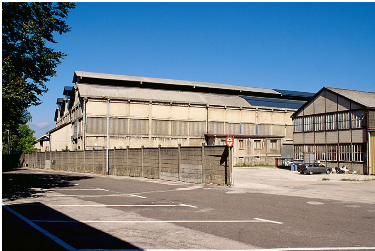
L'ancienne fonderie depuis le sud.
