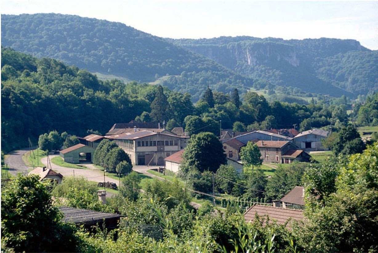
Vue générale depuis le nord.
