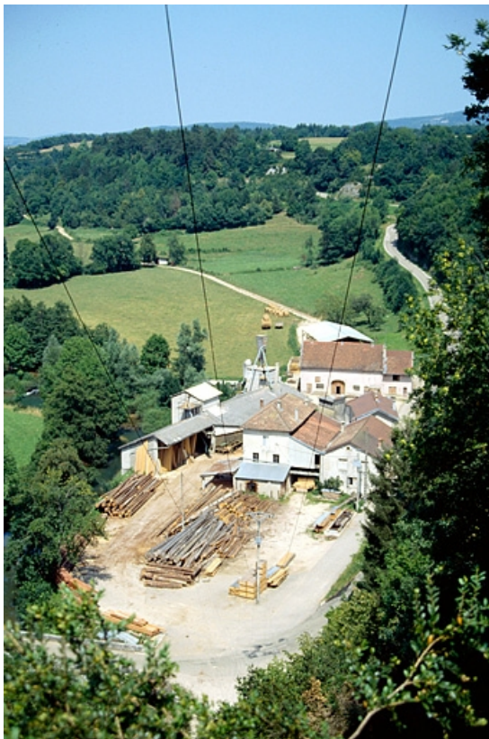
Vue d'ensemble plongeante depuis le sud.
