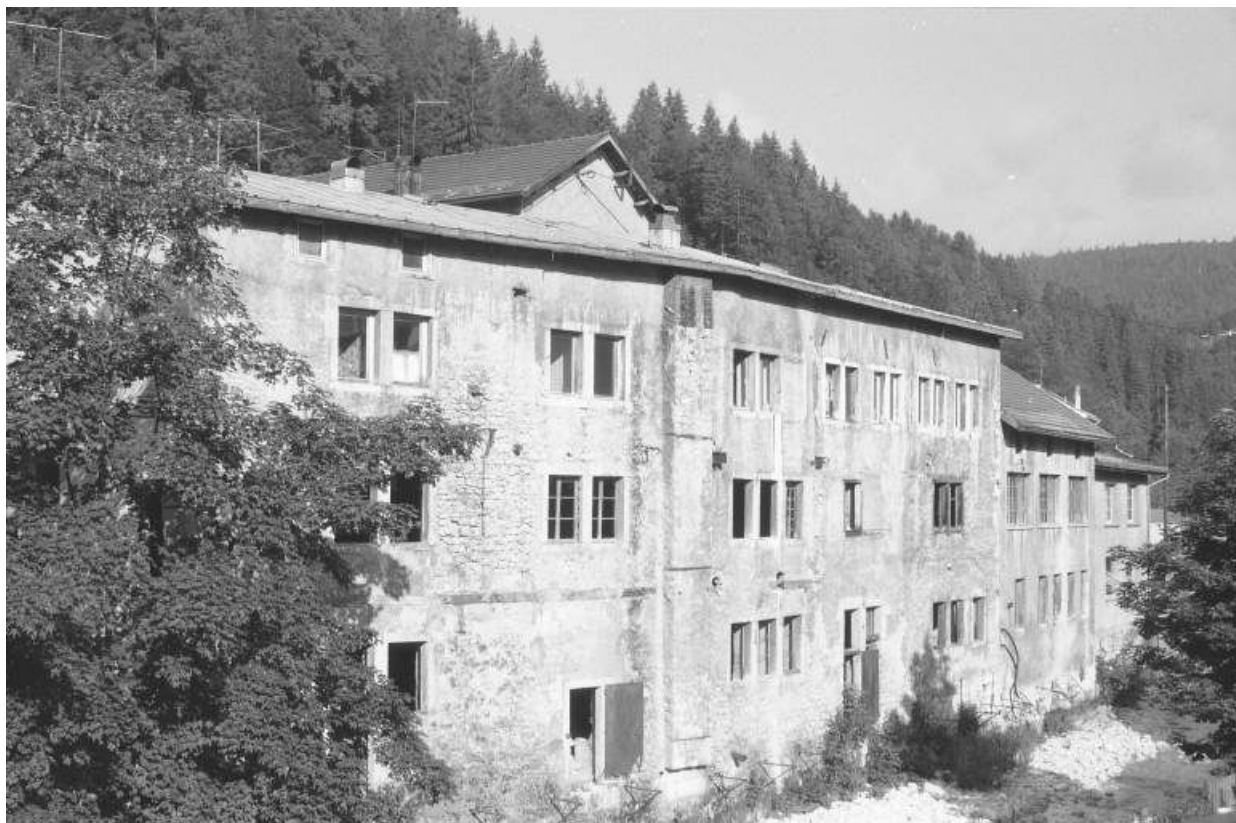
Façade sur la Bienne depuis l'est (amont).
