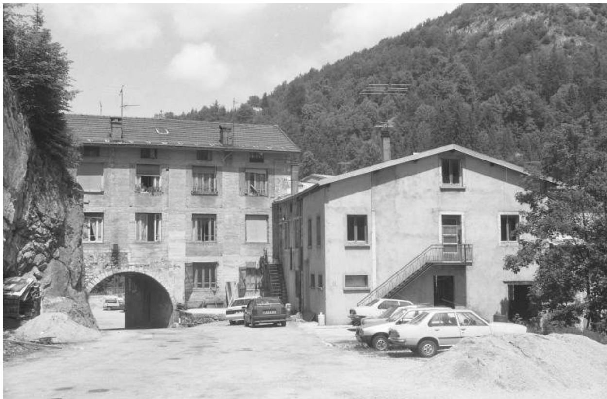
Vue d'ensemble depuis le sud-est (amont).
