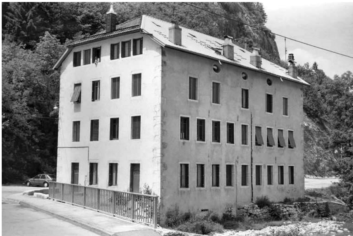
Façades antérieure et latérale droite.
