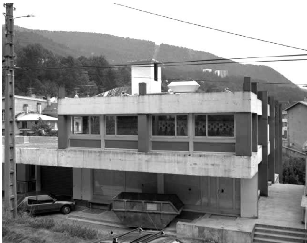
Atelier de fabrication des années 1970.
