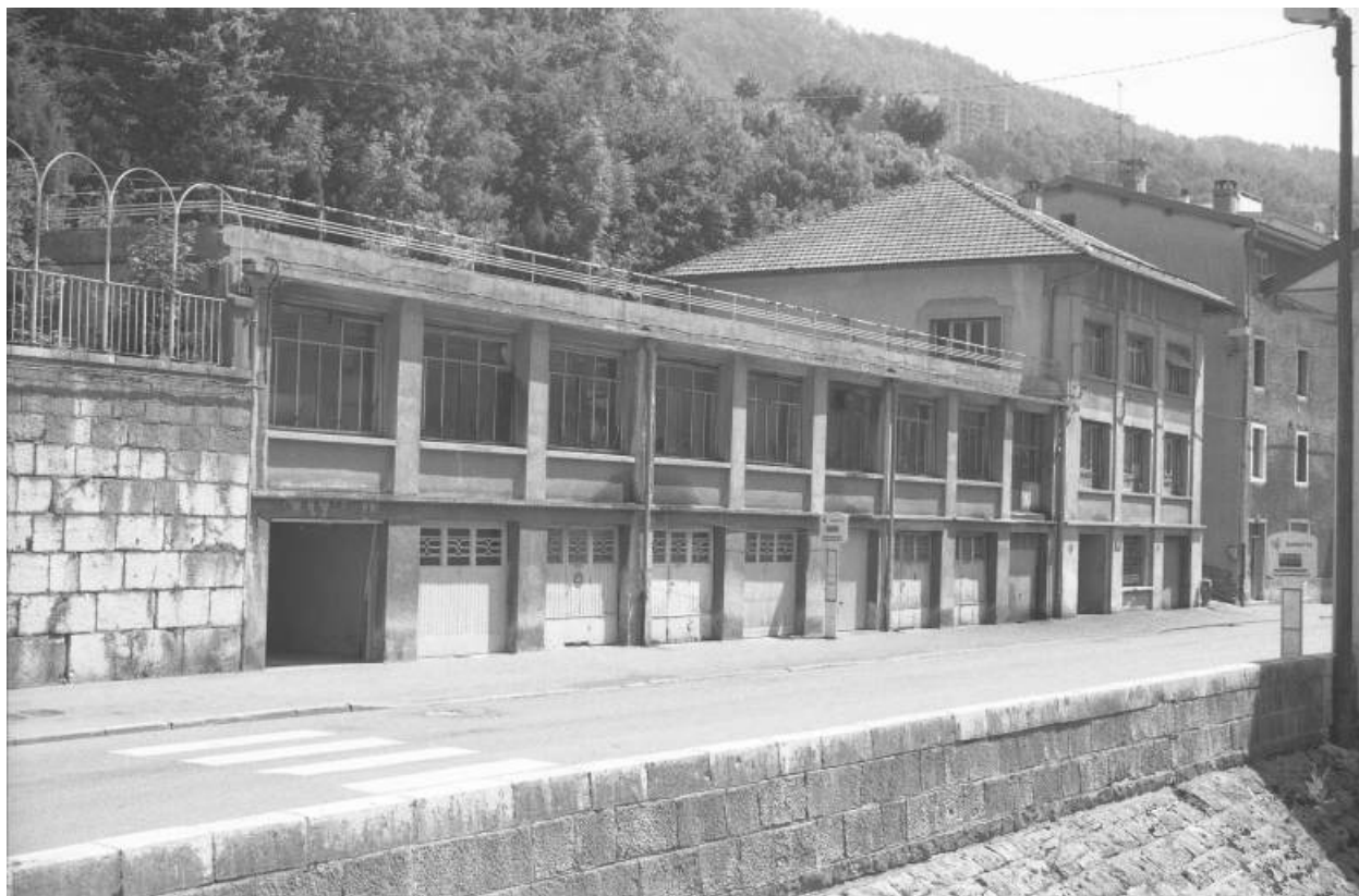
Façade antérieure de trois quarts gauche. 39, Morez, 37 et 37 bis rue de la République
