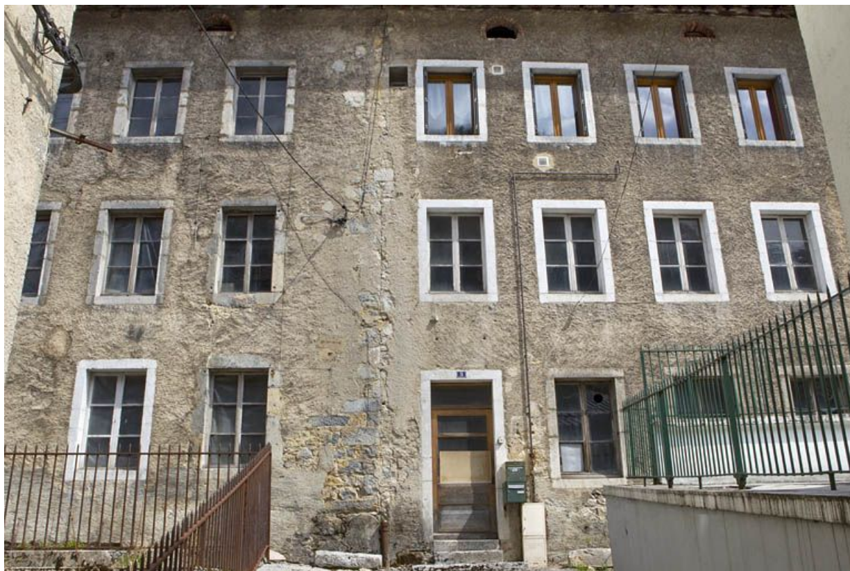
Ancienne usine de lunetterie de la coopérative Les Lunetiers réunis : élévation antérieure.
