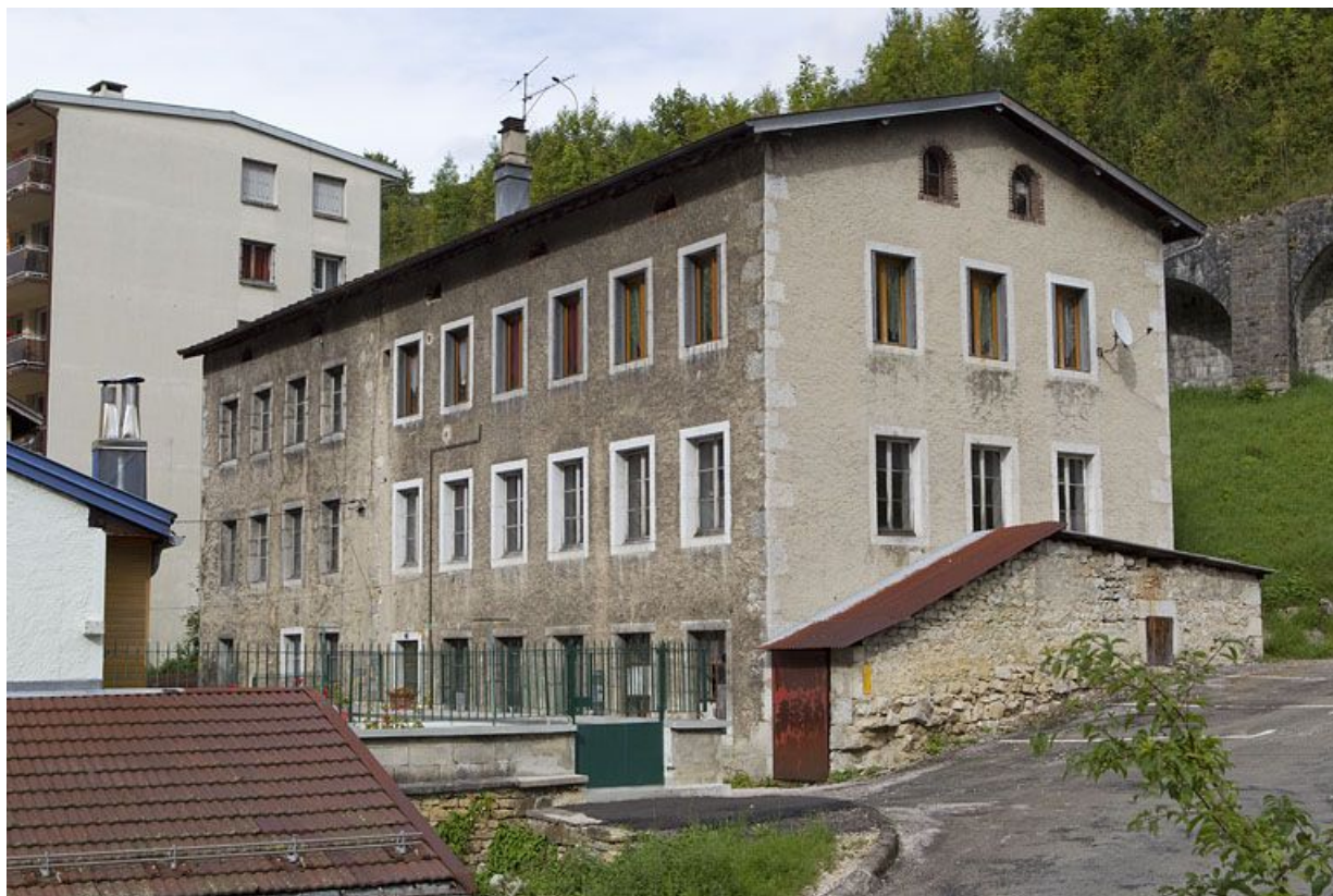
Ancienne usine de lunetterie de la coopérative Les Lunetiers réunis (5 rue de la Concorde). 39, Morez, 5 rue de la Concorde
