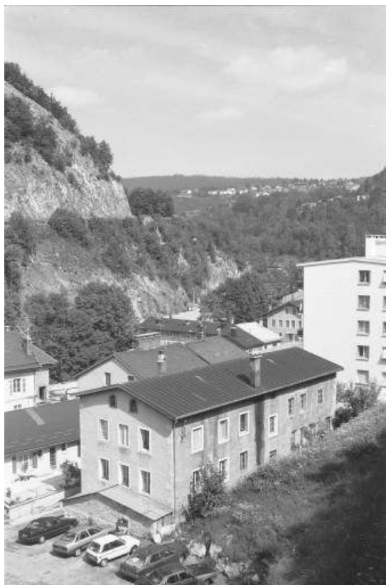
Vue d'ensemble plongeante depuis l'est.
