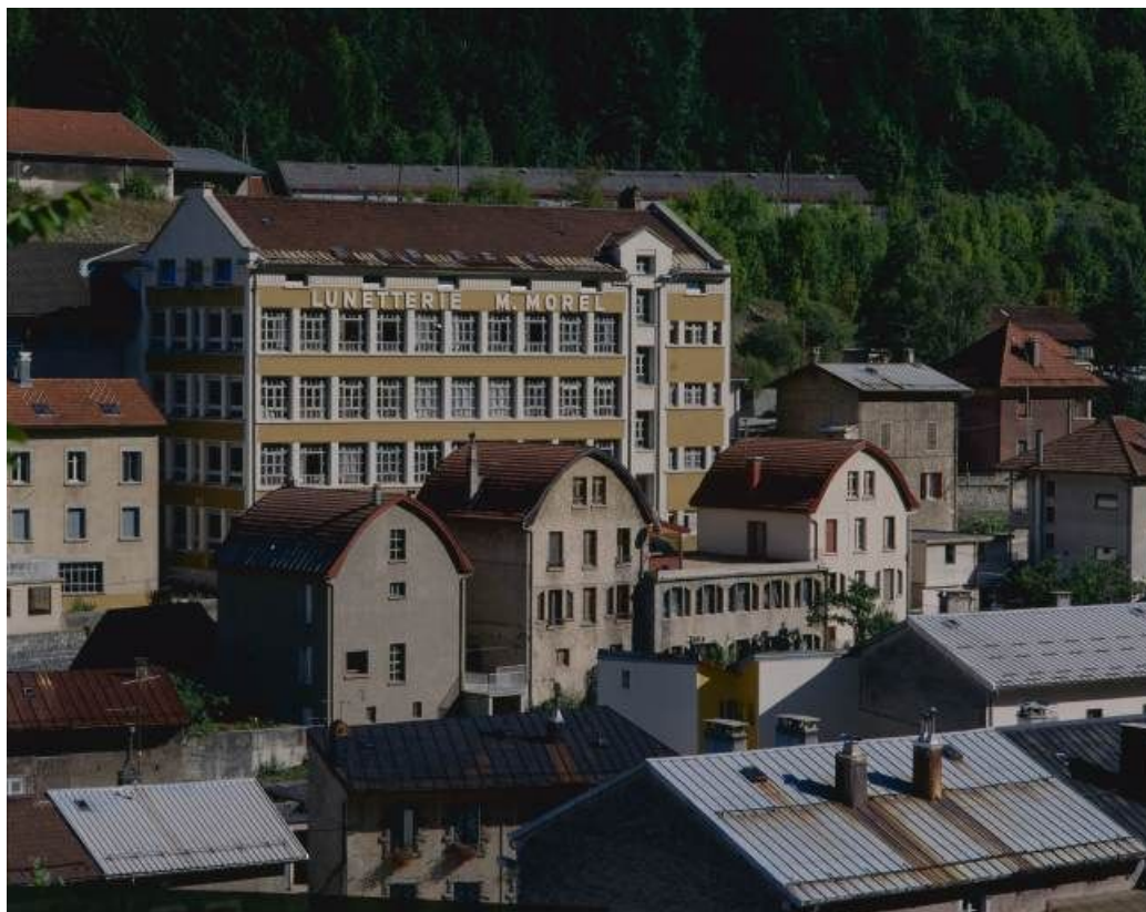
Façade postérieure du bâtiment de 1936, de trois quarts gauche.
