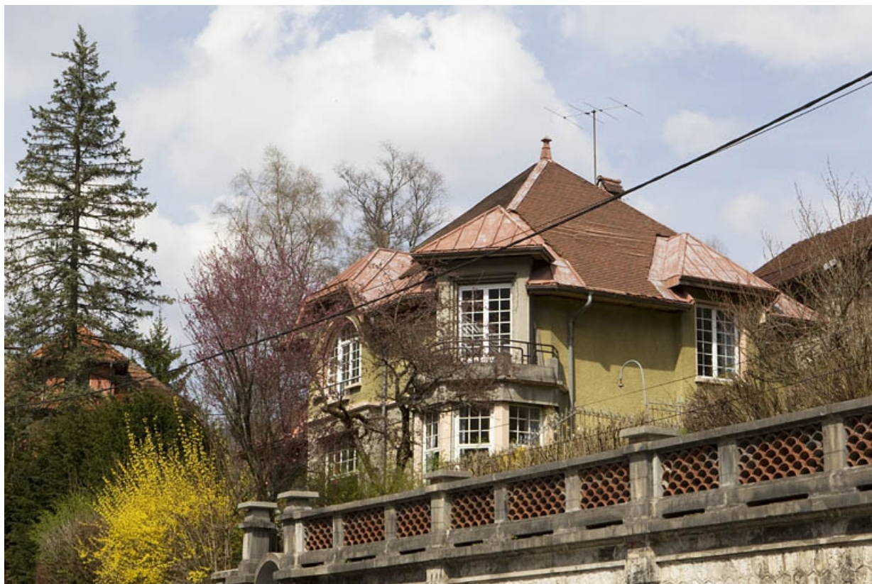
Logement patronal : vue d'ensemble, depuis le sud.
