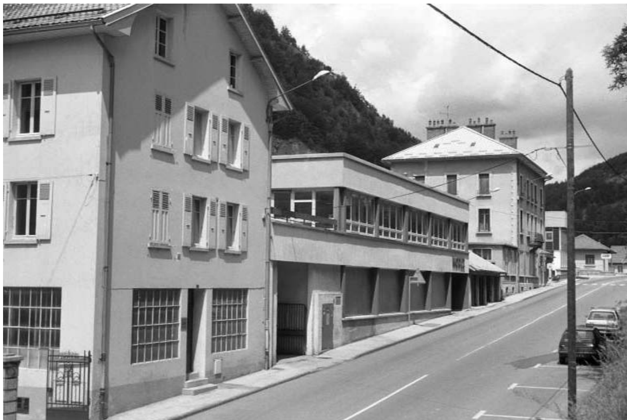
Avenue Charles de Gaulle : vue d'ensemble.
