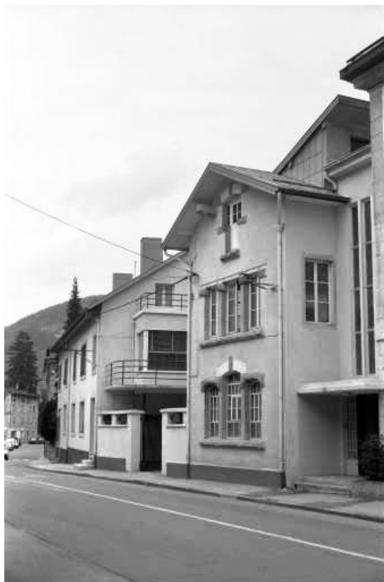
Rue de la République : vue d'ensemble.
