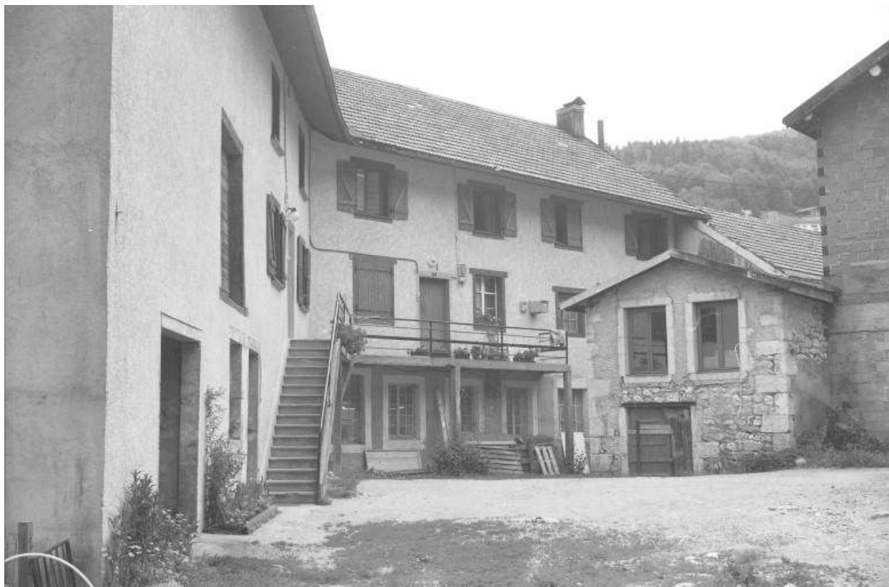
Ancienne clouterie : façades sur la cour.
