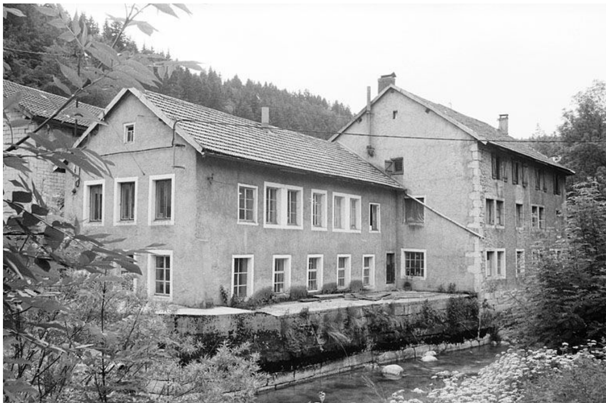
Ancienne clouterie : façades sur la Bienne.
