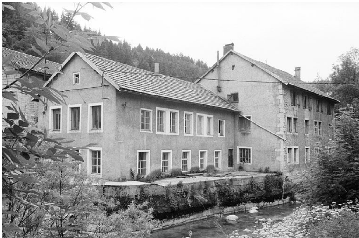
Ancienne clouterie : façades sur la Bienne.
