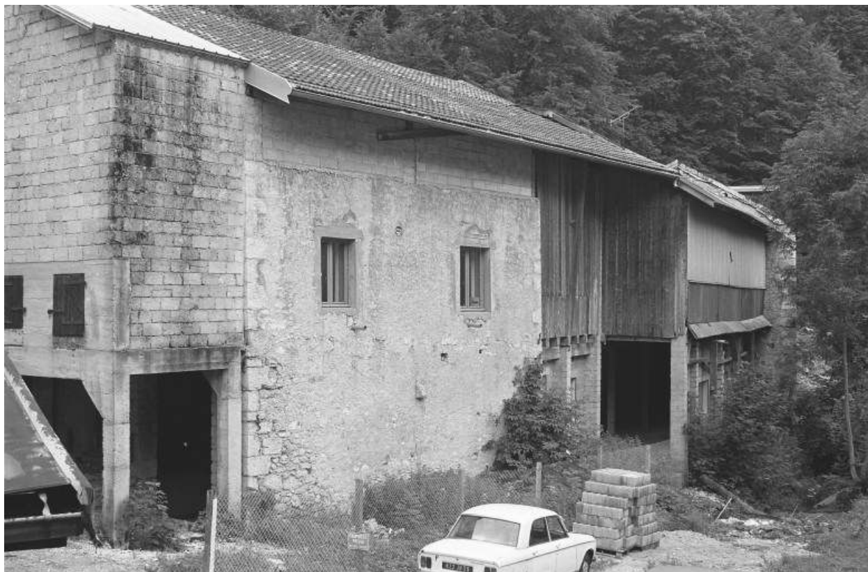
Atelier de fabrication et remise à automobile en bordure de la rue des Forges : façade sur cour. 39, Morez, 2 à 10 rue des Forges
