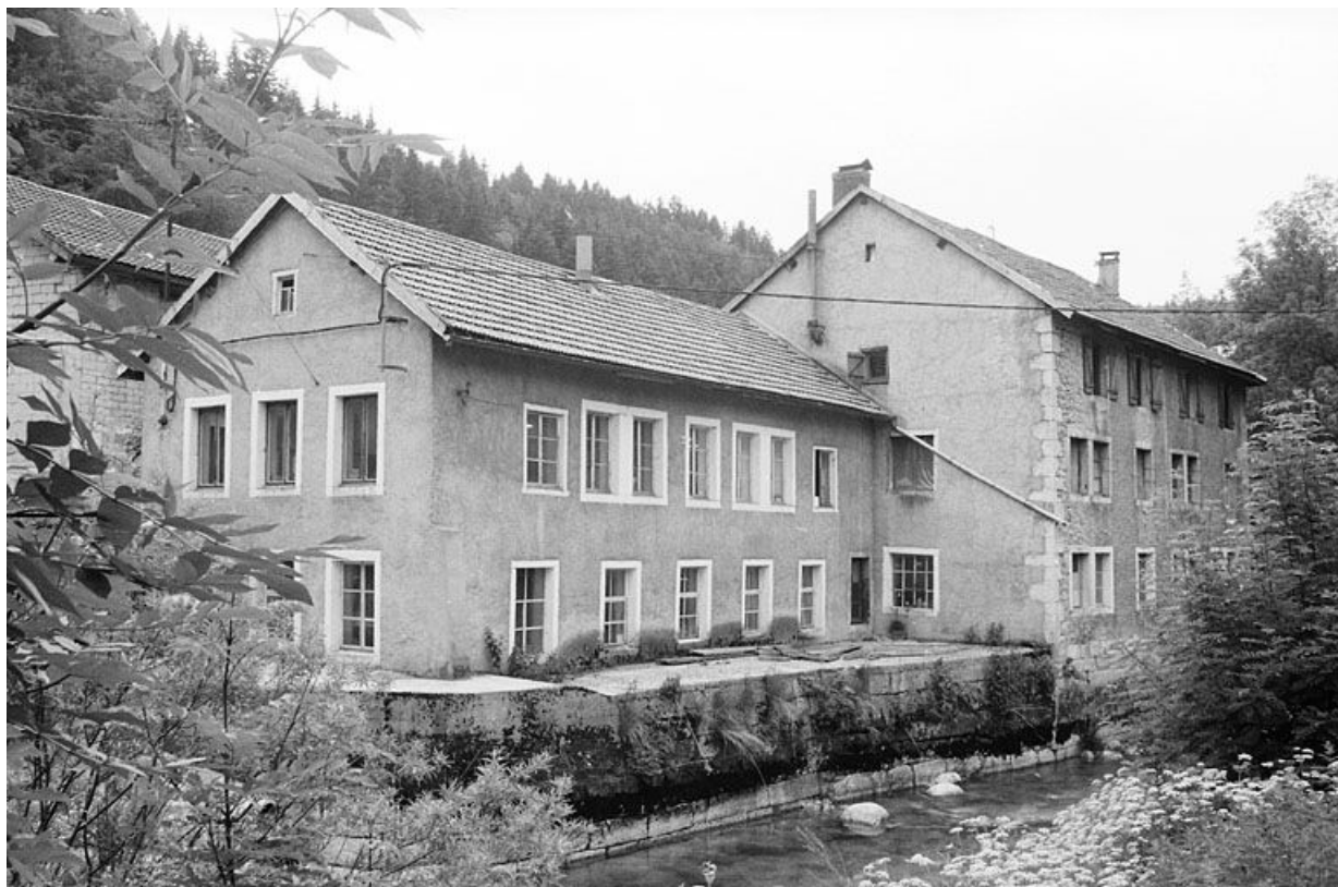
Ancienne clouterie : façades sur la Bienne.
