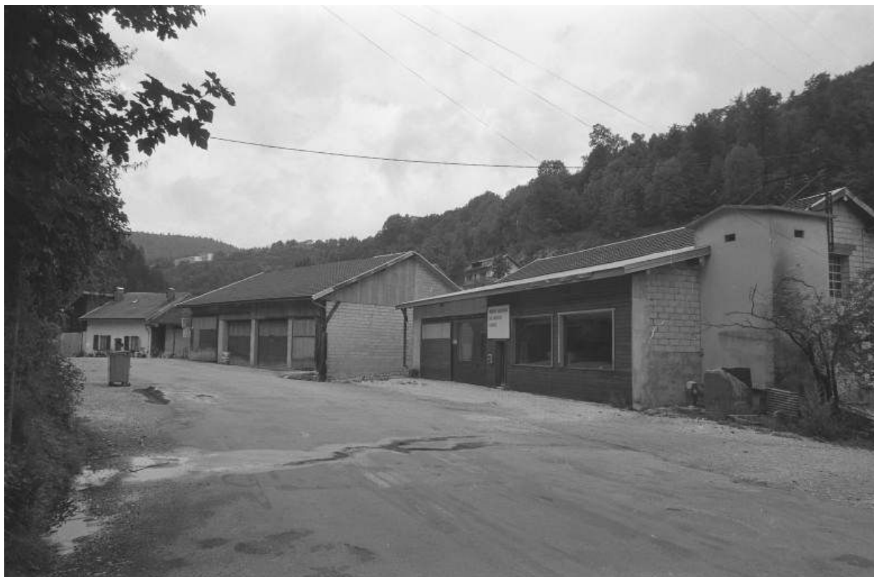
Vue d'ensemble des bâtiments récents en bordure de la rue des Forges.
