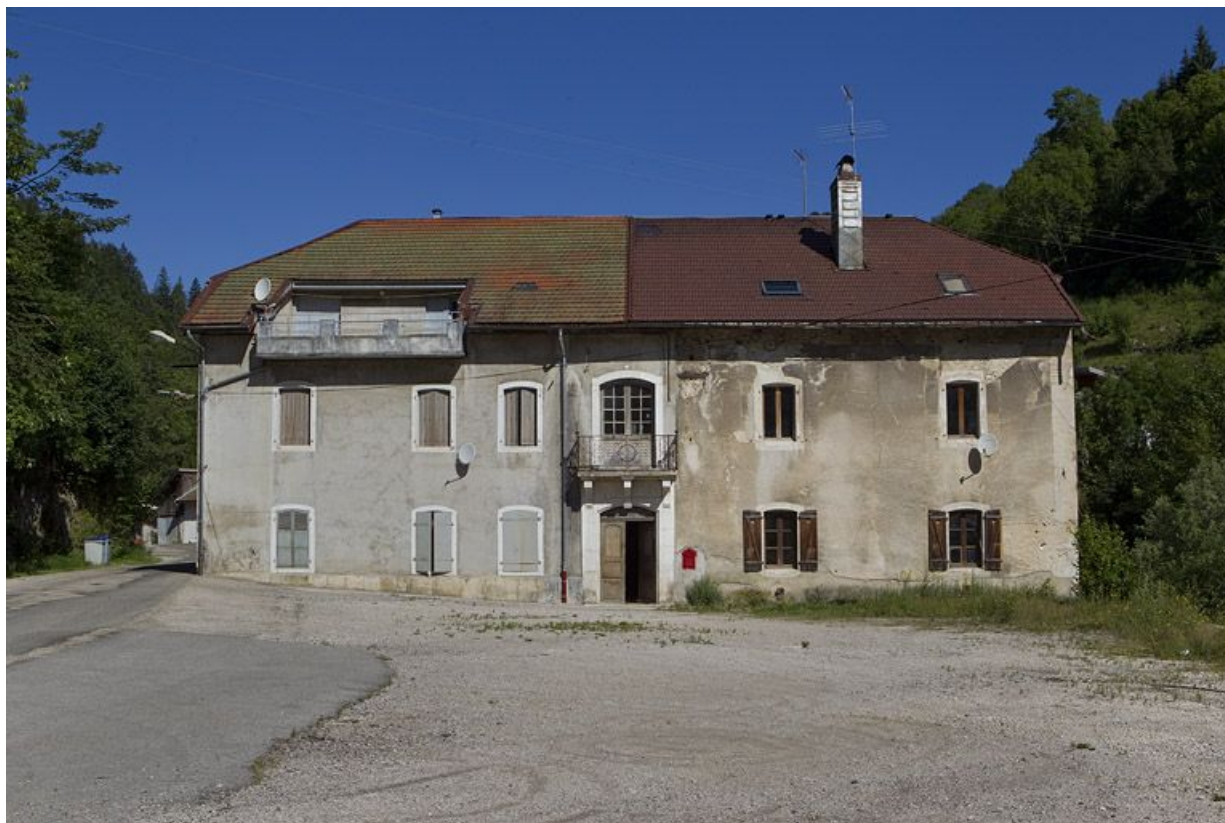
Ancienne usine de transformation des métaux puis usine d'horlogerie et scierie Prost Frères (2 à 10 rue des Forges).
