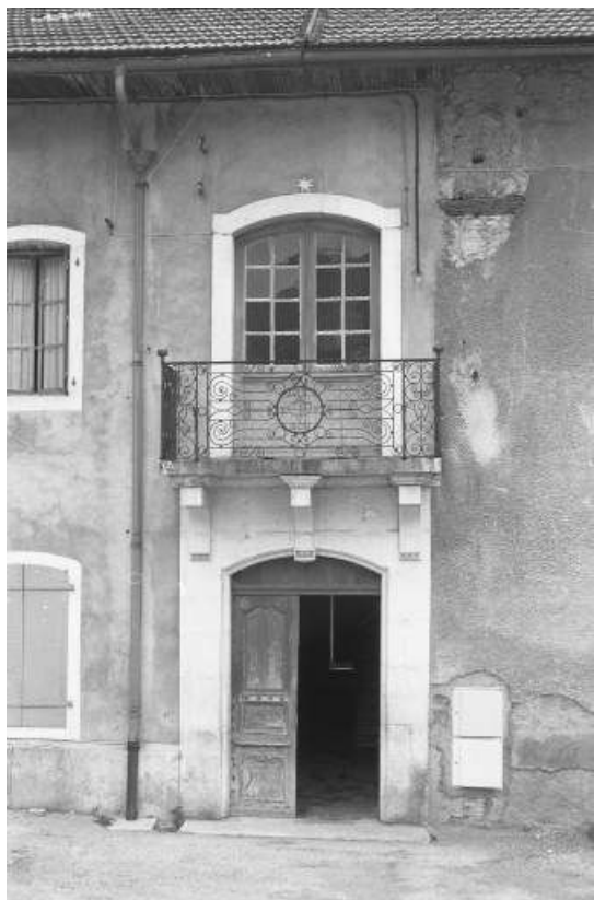
Logement patronal : porte d'entrée et balcon.
