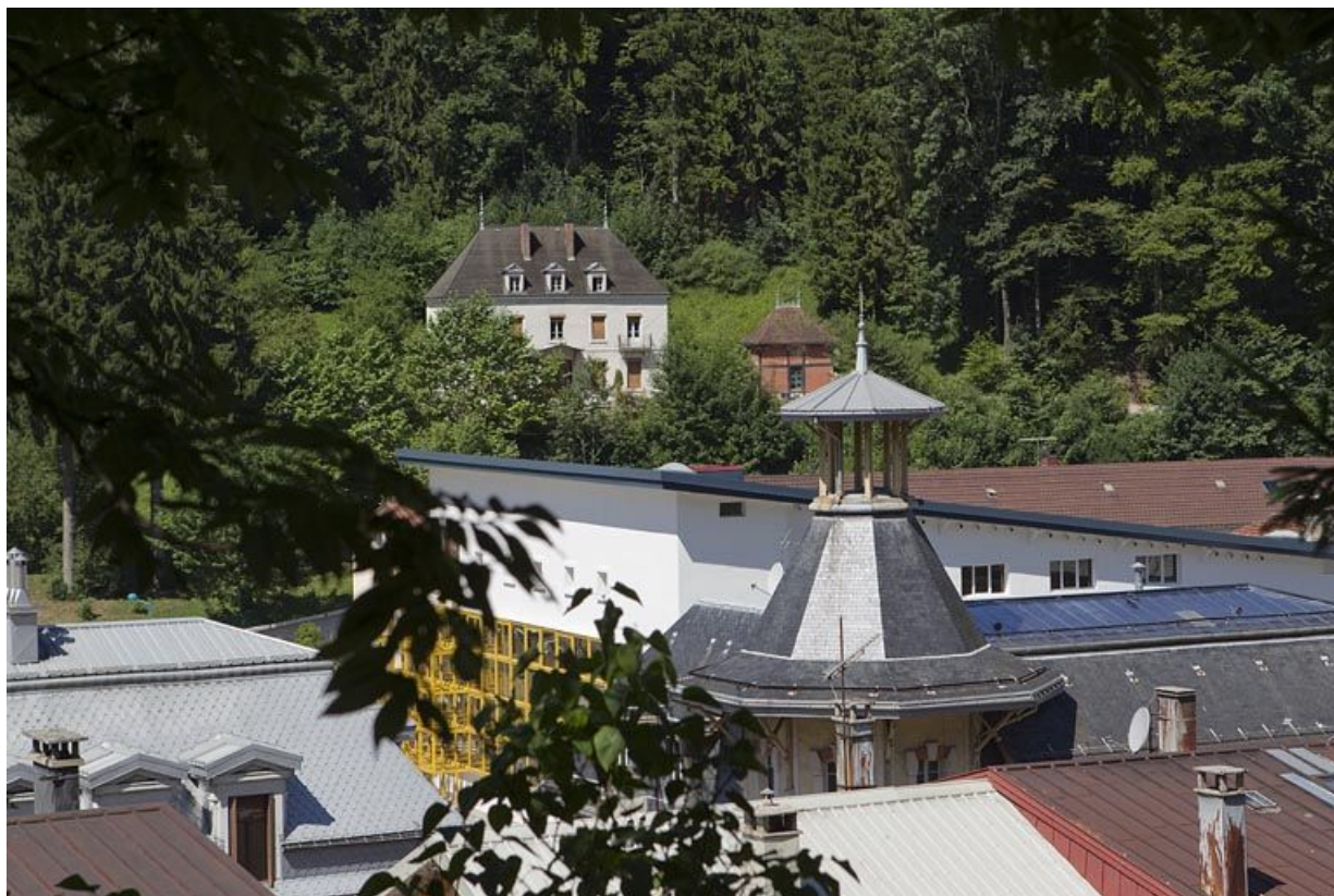
Maison de notable (19e siècle) au n° 6 rue Lamartine. Maison (AE 145) servant autrefois de logement patronal pour l'usine de lunetterie J.-B. Jacquemin (1 à 8 rue de l'Industrie). Lanterne de la poste au premier plan, à l'avant de la salle des fêtes. 39, Morez, 1, 1 bis, 4 à 8 rue de l' Industrie
