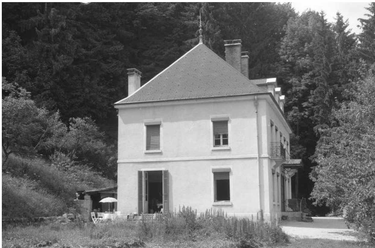
Façade latérale gauche du logement patronal.
