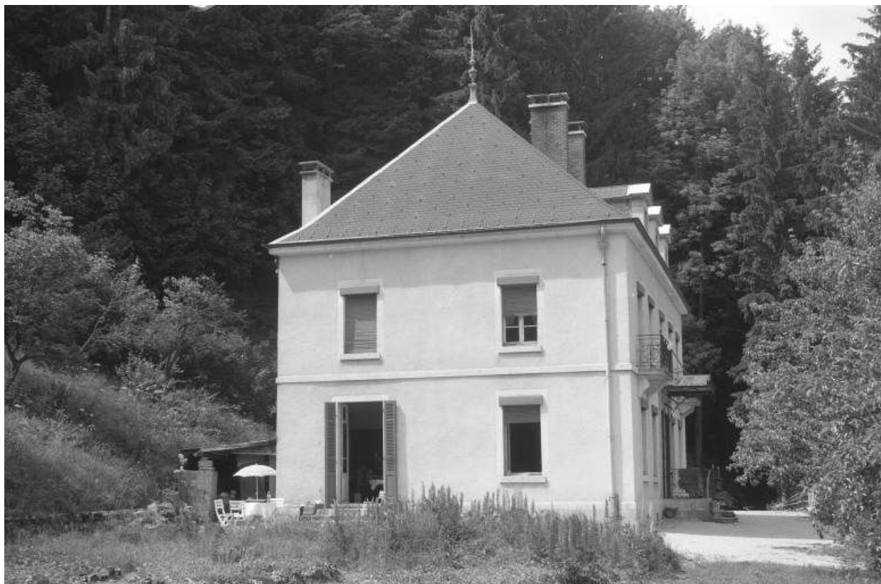
Façade latérale gauche du logement patronal.
