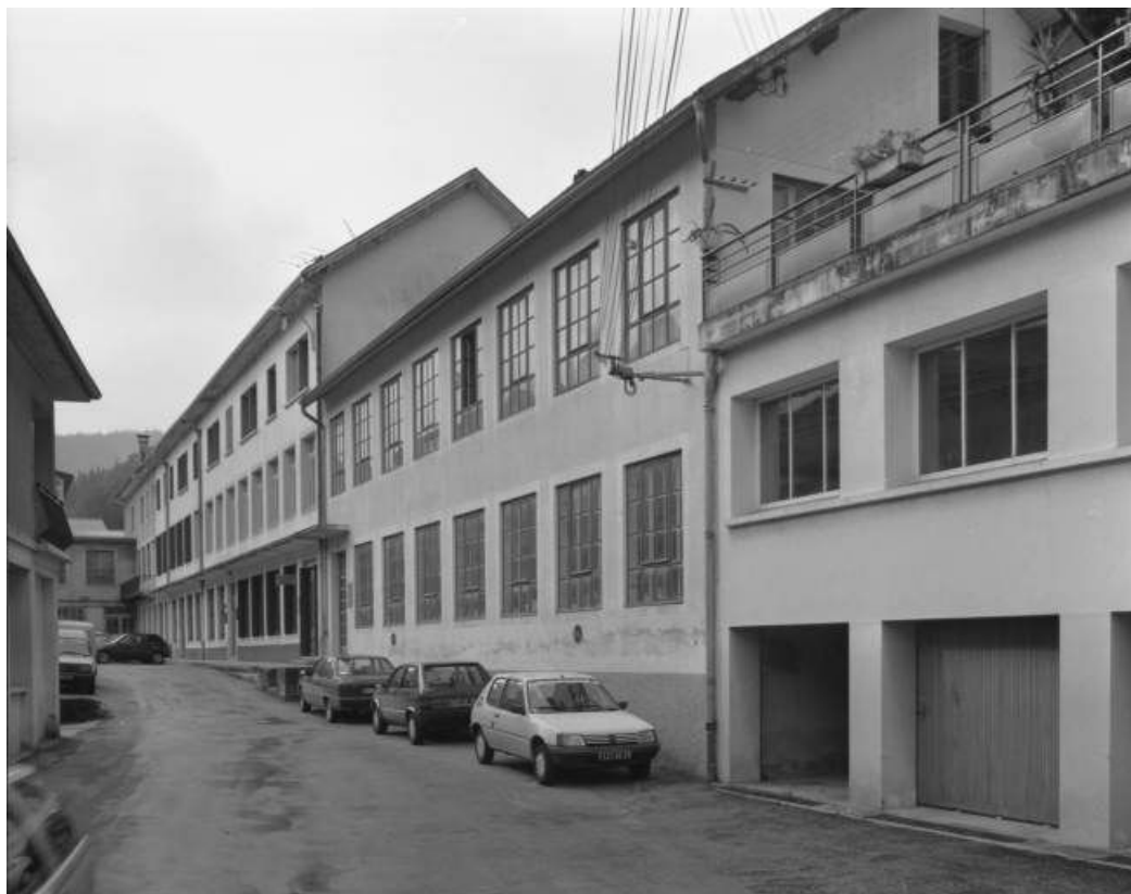
Façade antérieure de trois quarts droite. 39, Morez, 1, 1 bis, 4 à 8 rue de l' Industrie
