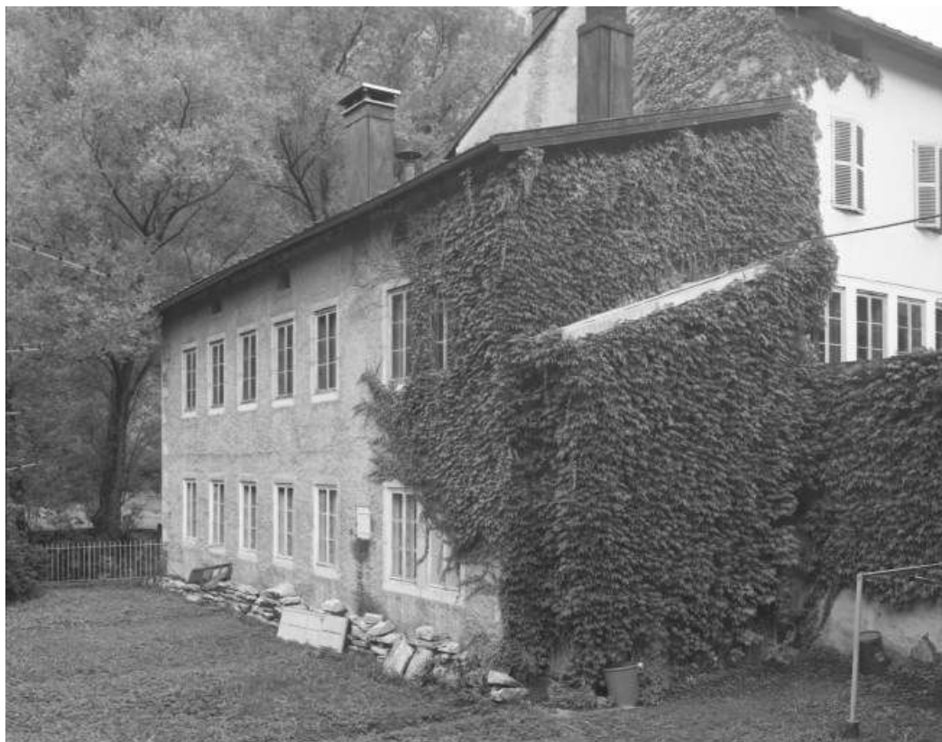
Bâtiment en location au 68 rue de la République.
