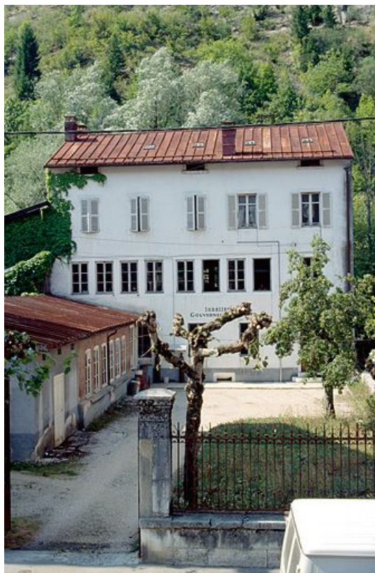
Vue d'ensemble depuis la rue de la République.
