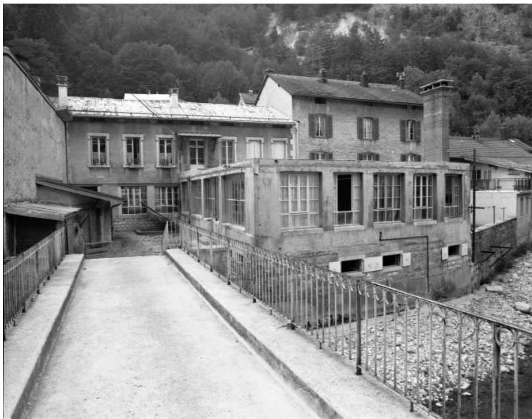
Façade antérieure de l'usine sur la rue de la République et passerelle sur la Bienne. 39, Morez, 11 rue de l' Industrie
