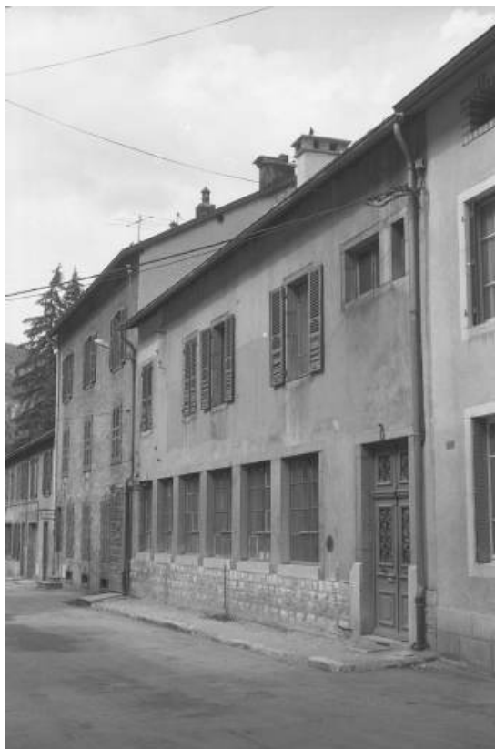
Façade de l'usine sur la rue de l'Industrie.
