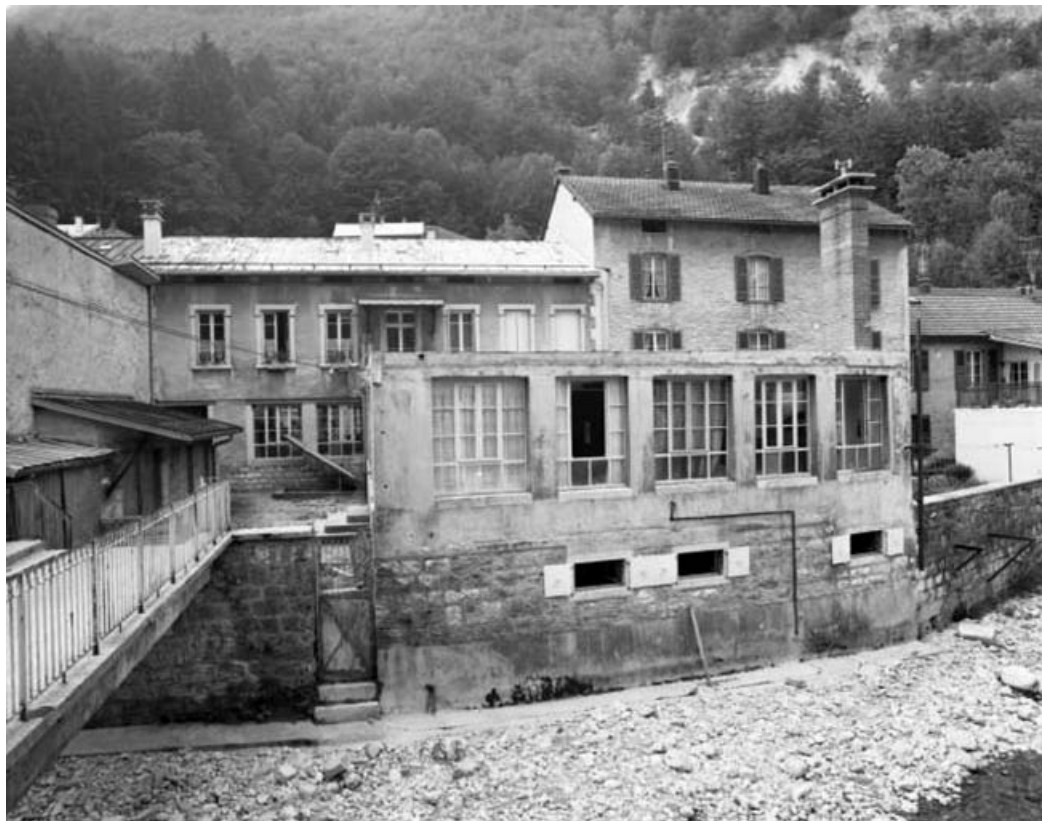
Façade antérieure de l'usine sur la rue de la République.
