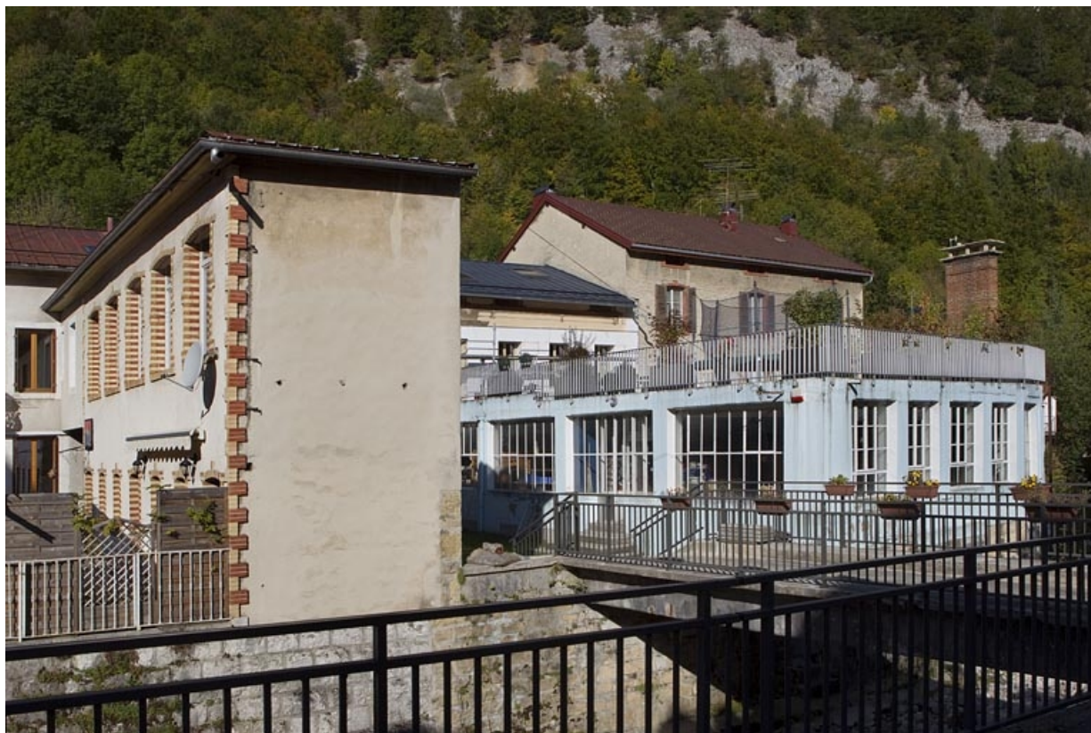
Vue d'ensemble depuis la rue de la République.
