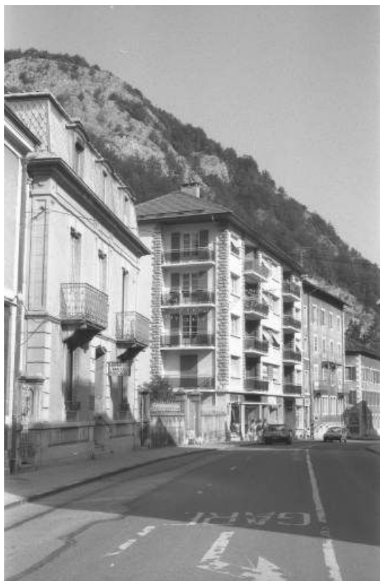
Vue d'ensemble des façades sur la rue de la République (depuis le sud-est). 39, Morez, 1 à 13 cour Paul Odobey
