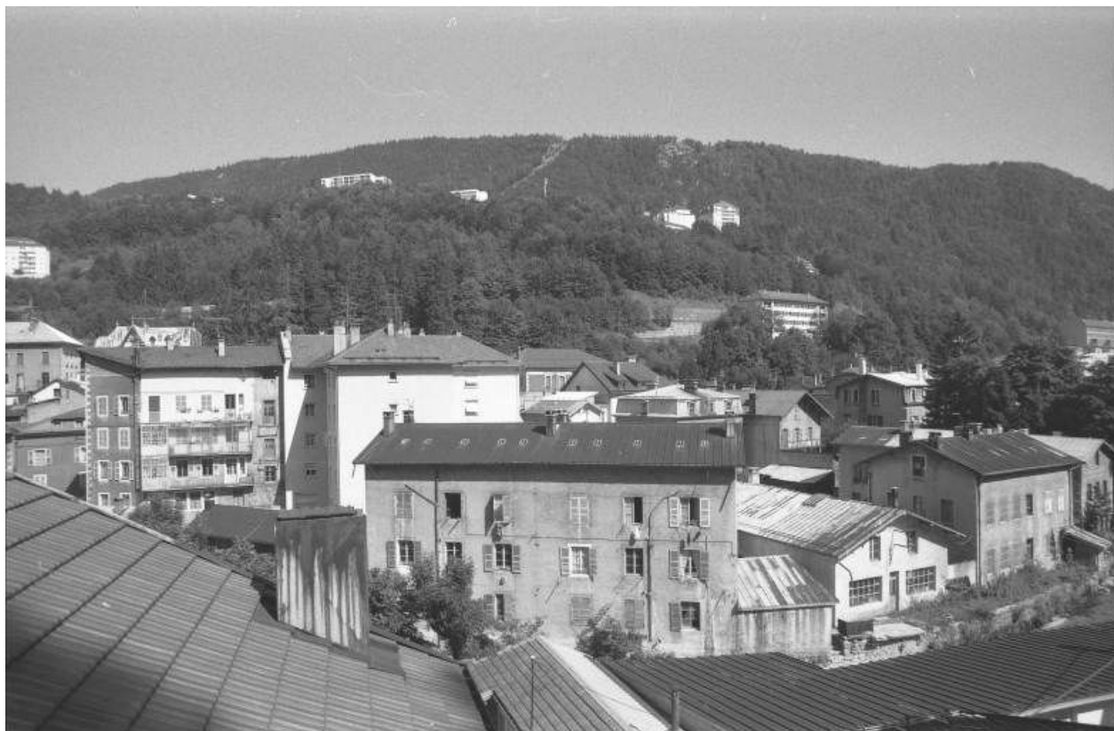
Vue d'ensemble des façades sur la Bienne (depuis l'ouest).
