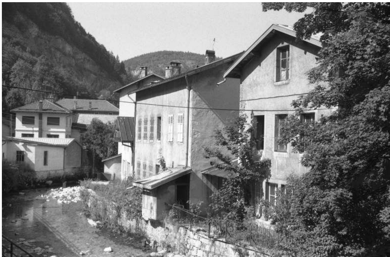
Façade de l'ancienne fonderie, sur la Bienne.
