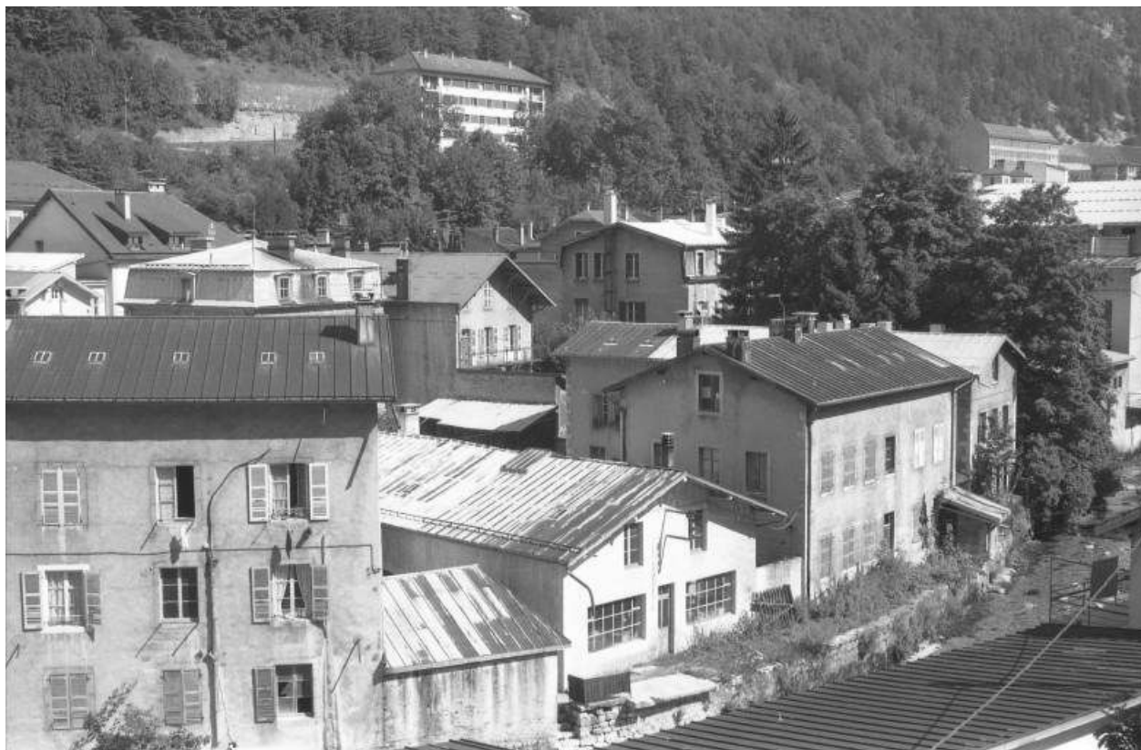
Façade latérale droite de l'atelier de fabrication et ancienne fonderie, sur la Bienne. 39, Morez, 1 à 13 cour Paul Odobey
