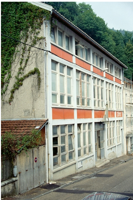
1ère unité (18 rue Pasteur) : façade antérieure de trois quarts gauche. 39, Morez, 18 rue Pasteur
