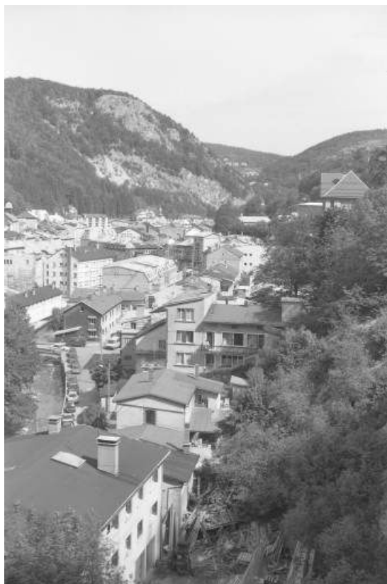
Vue d'ensemble plongeante depuis le sud-est.
