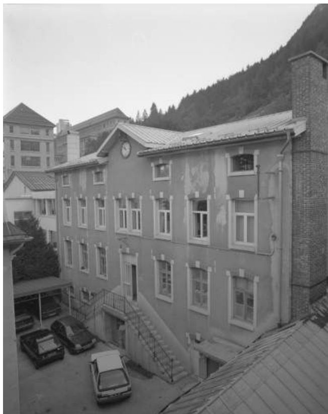
Site ancien : façade antérieure de l'usine, de trois quarts droite. 39, Morez, 11, 13 rue Wladimir Gagneur
