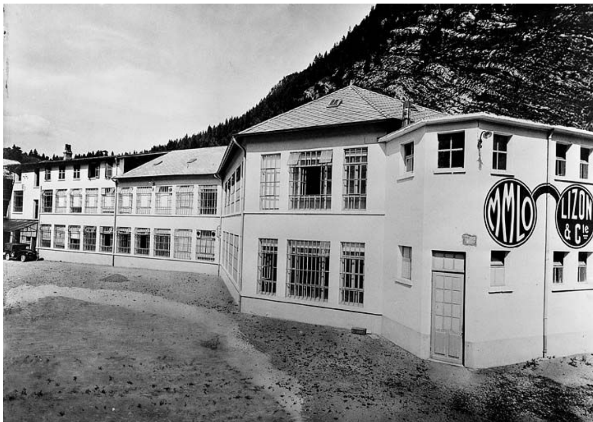
Ateliers de fabrication au long de la Bienne.
