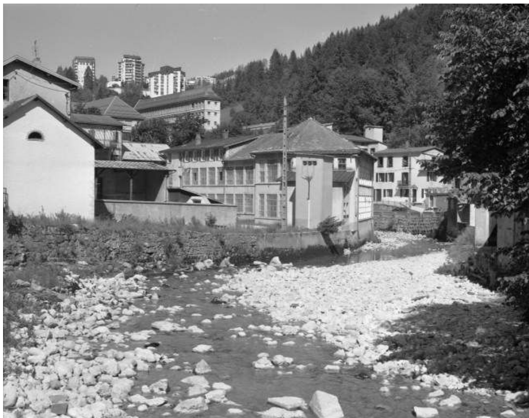
Vue d'ensemble depuis la Bienne, au sud-ouest.
