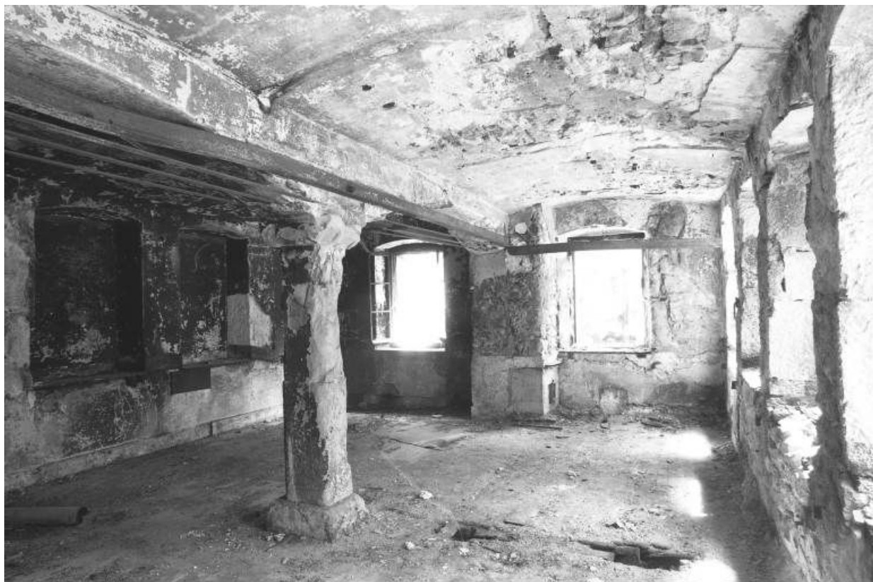
Bâtiment 6-8 rue Victor Poupin : intérieur d'une pièce à l'étage.
