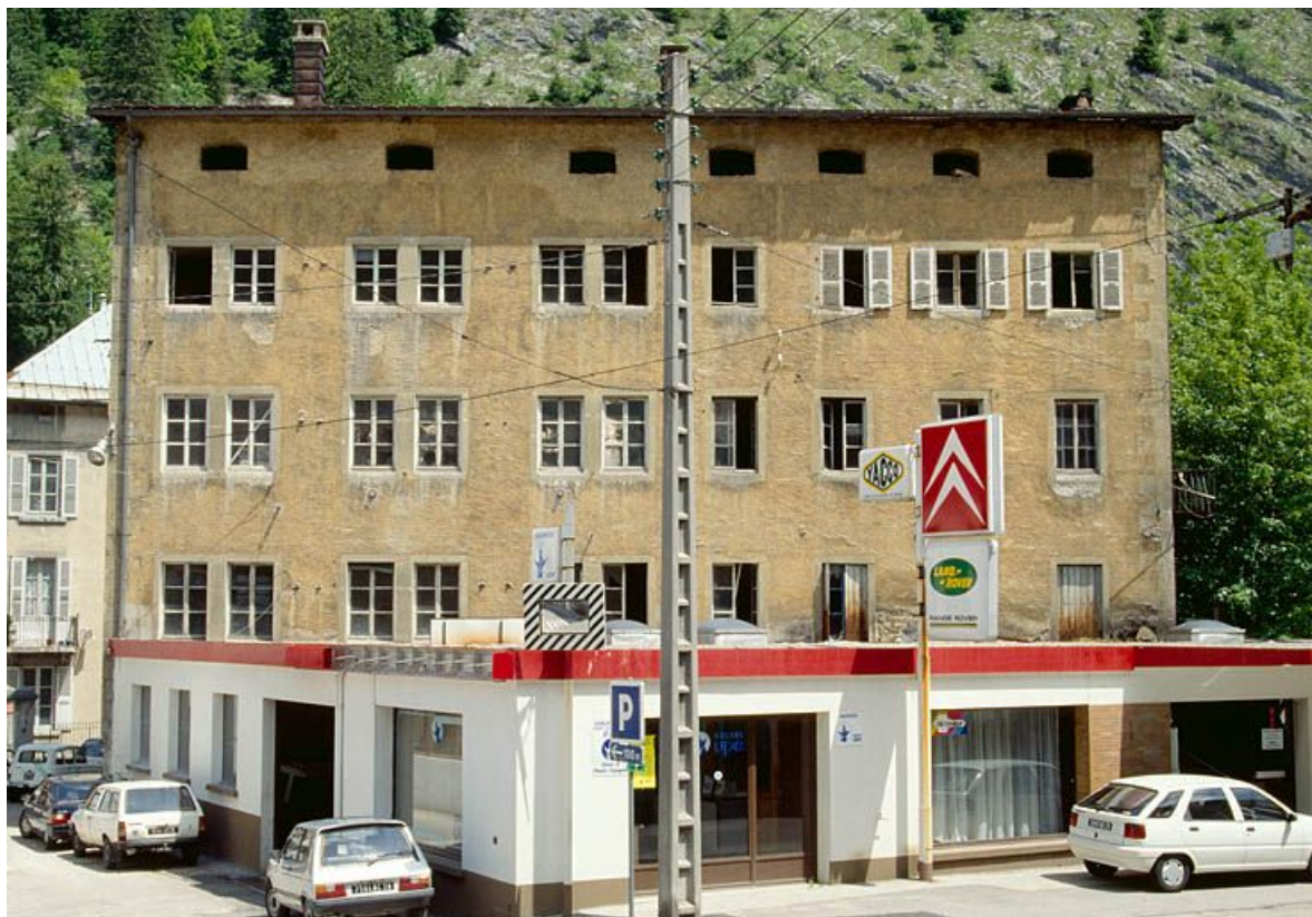
Bâtiment 6-8 rue Victor Poupin : façade antérieure. 39, Morez, 199 rue de la République
