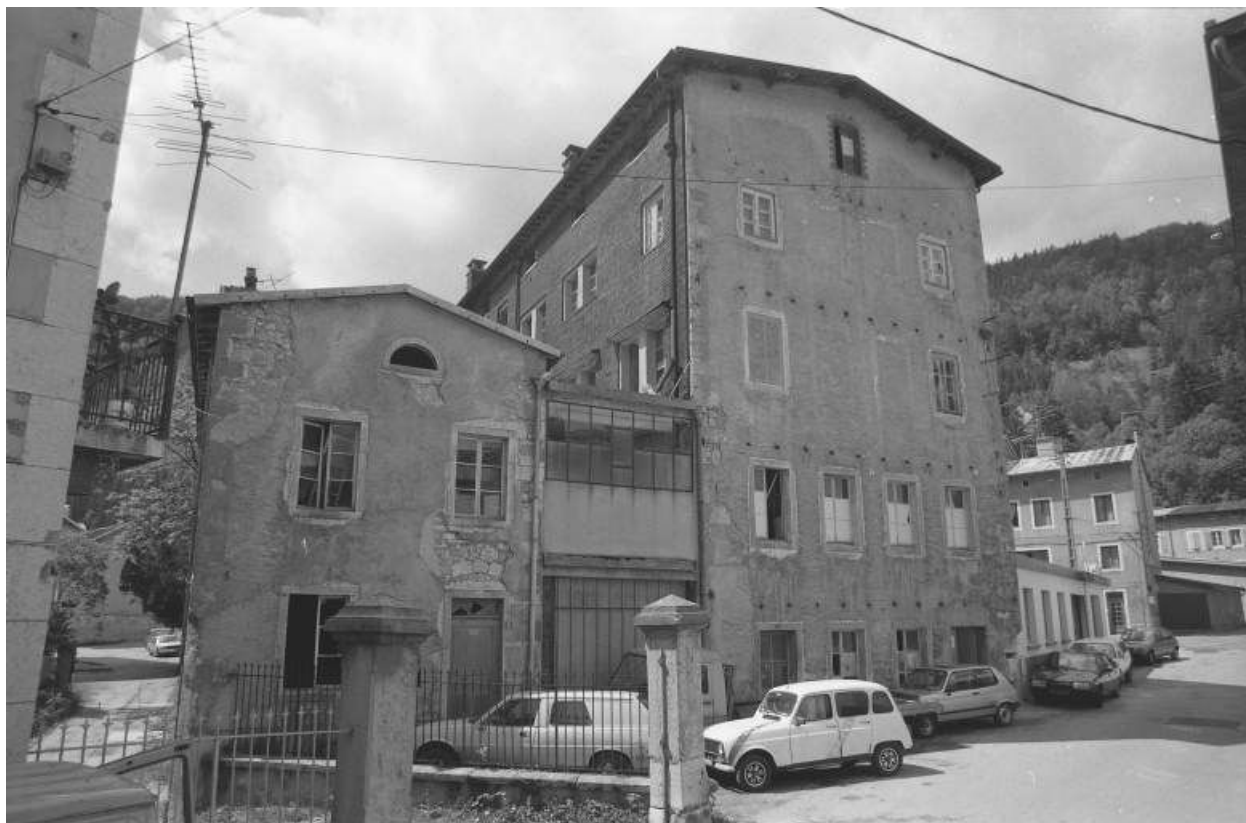
Bâtiment 6-8 rue Victor Poupin : façade latérale gauche. 39, Morez, 199 rue de la République
