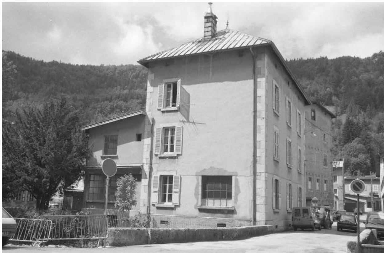
2e bâtiment rue Victor Poupin : façades postérieure et latérale gauche. 39, Morez, 199 rue de la République
