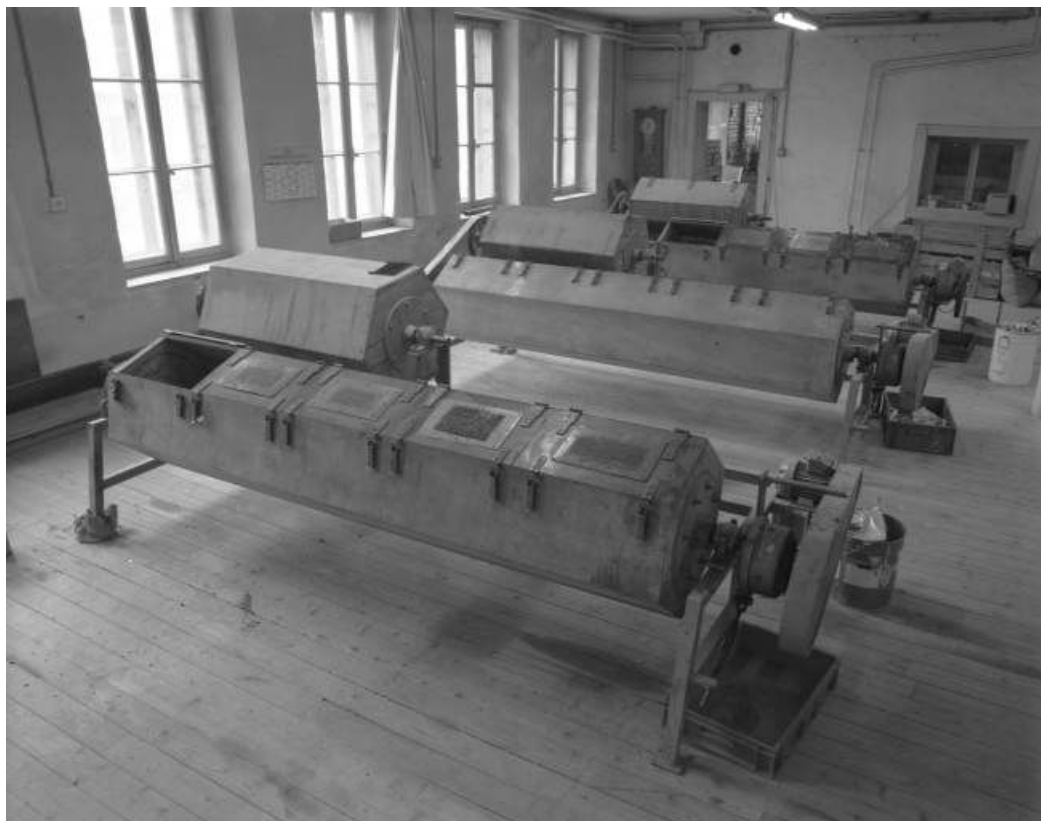
Ateliers de fabrication (1928-1929) : machines dans l'atelier à l'étage. 39, Morez, 199 rue de la République
