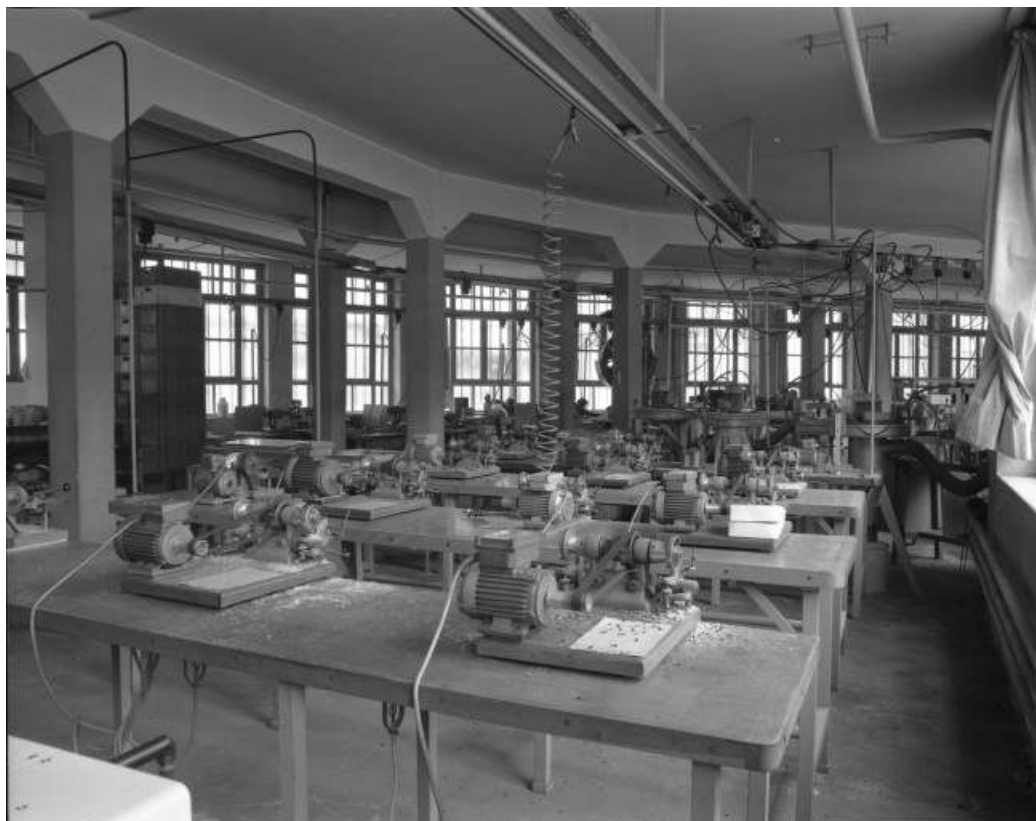
Ateliers de fabrication (1928-1929) : vue d'ensemble du rez-de-chaussée, depuis le fond. 39, Morez, 199 rue de la République
