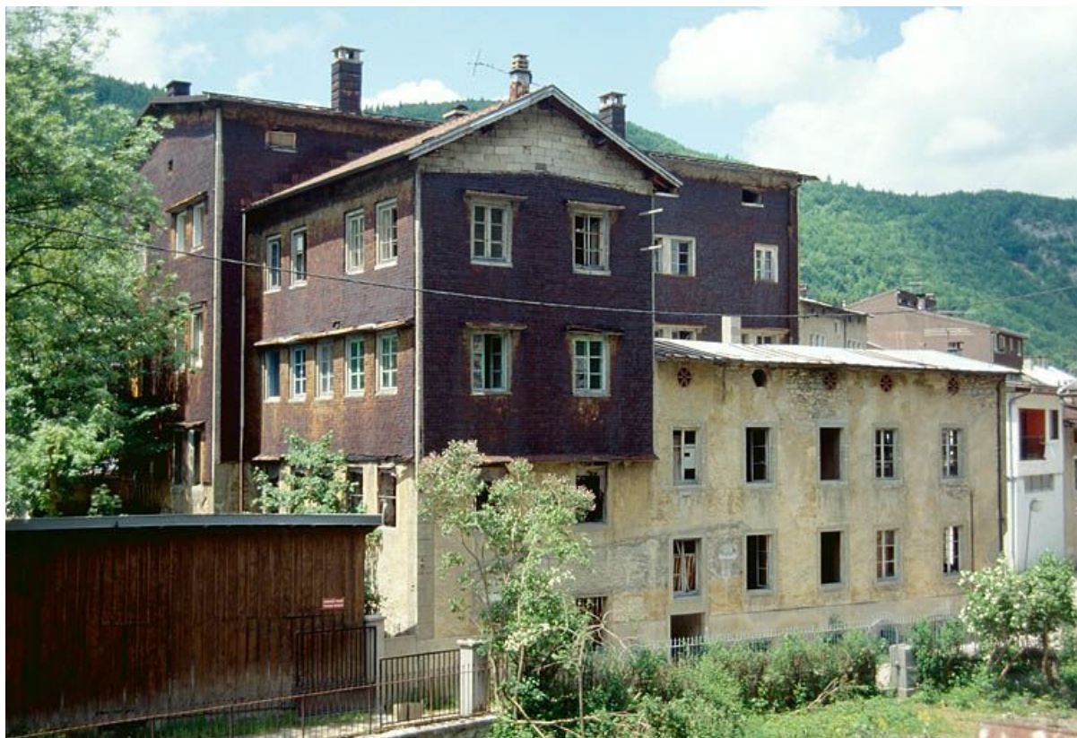
Bâtiment 6-8 rue Victor Poupin : façade postérieure. 39, Morez, 199 rue de la République
