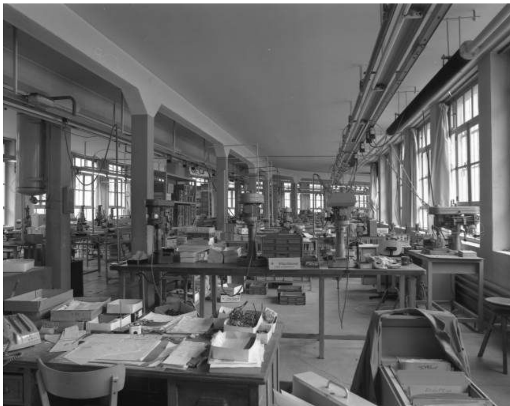
Ateliers de fabrication (1928-1929) : vue d'ensemble du rez-de-chaussée, depuis l'entrée. 39, Morez, 199 rue de la République
