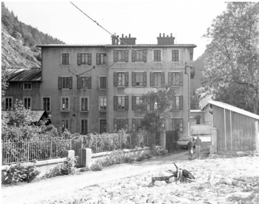
Logement patronal et anciens bureaux (1892) : façade latérale gauche. 39, Morez, 199 rue de la République
