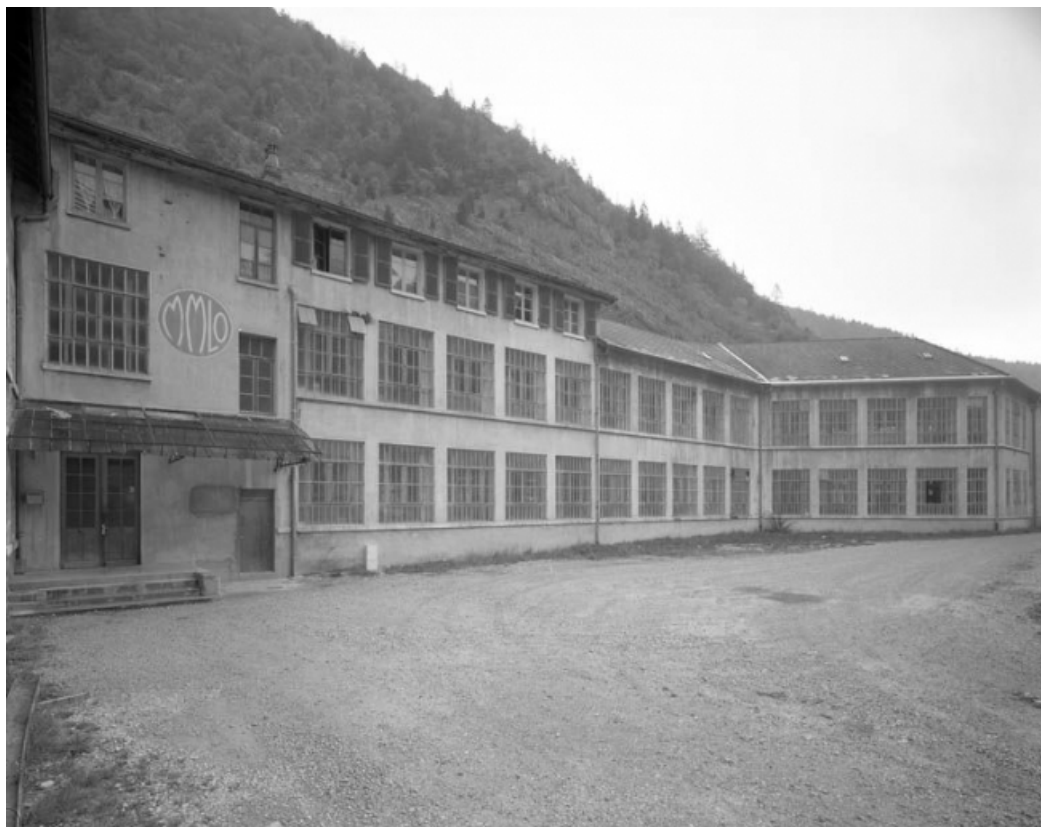
Ateliers de fabrication près de la Bienne (1928-1929) : façade antérieure.
