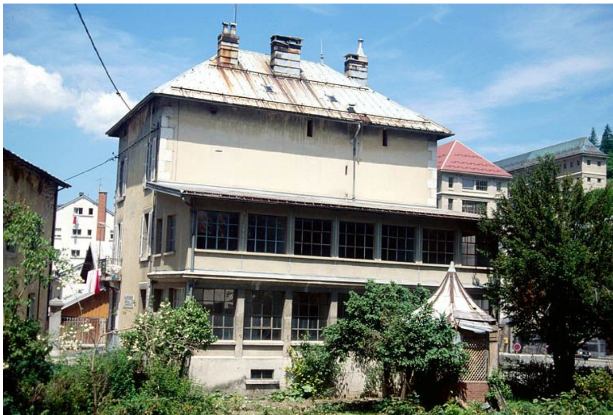
2e bâtiment rue Victor Poupin : façade latérale droite.
