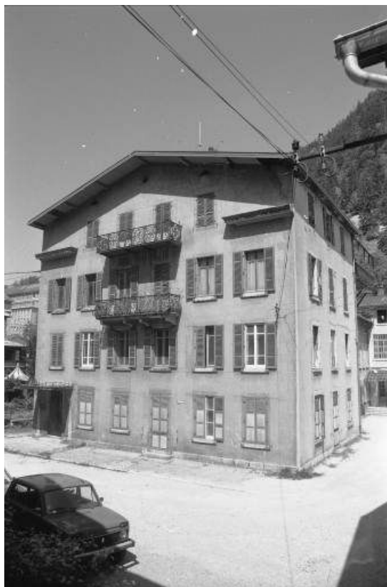
Logement patronal et anciens bureaux (1892) : façade antérieure.
