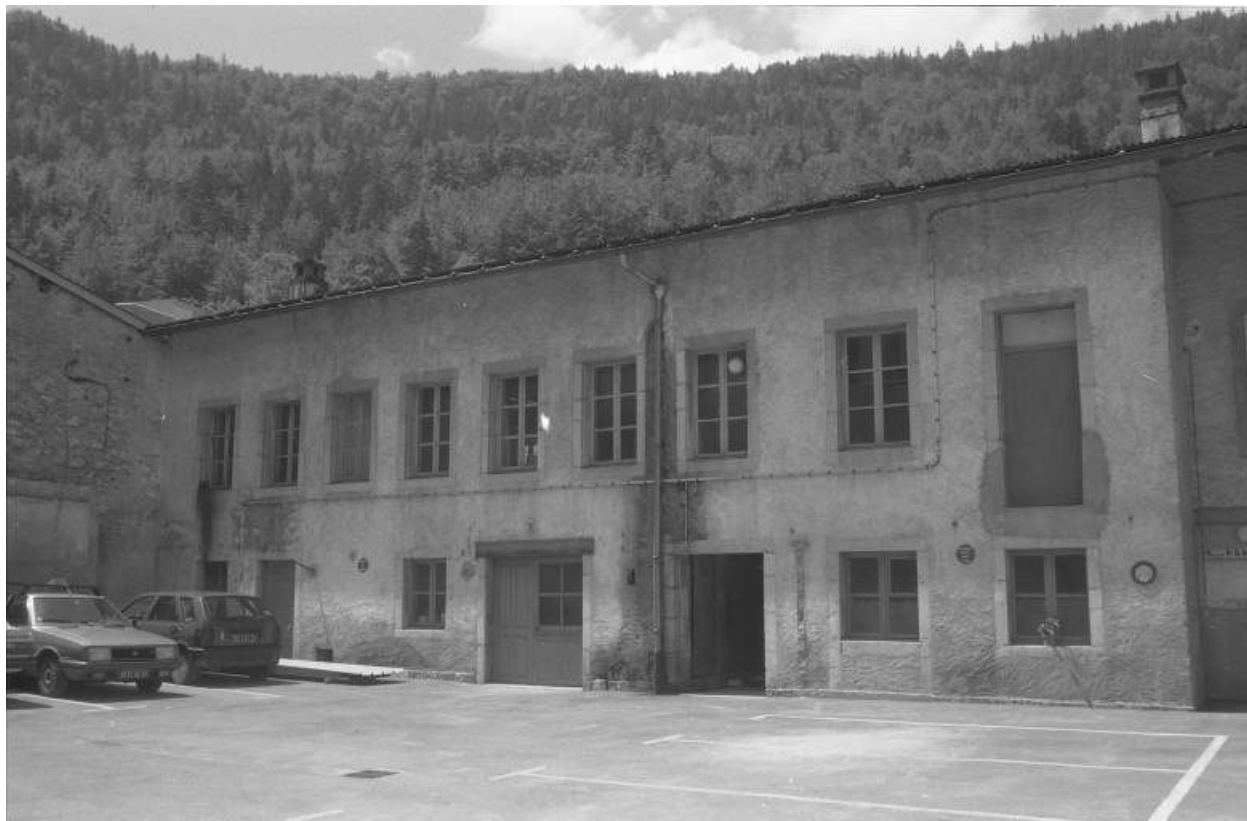
Façade antérieure des ateliers en fond de cour, aux n° 196 et 198.
