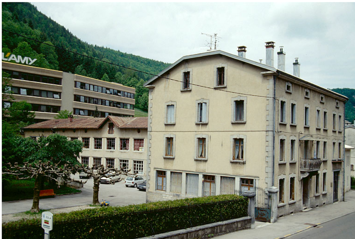
Logement patronal et atelier de fabrication.
