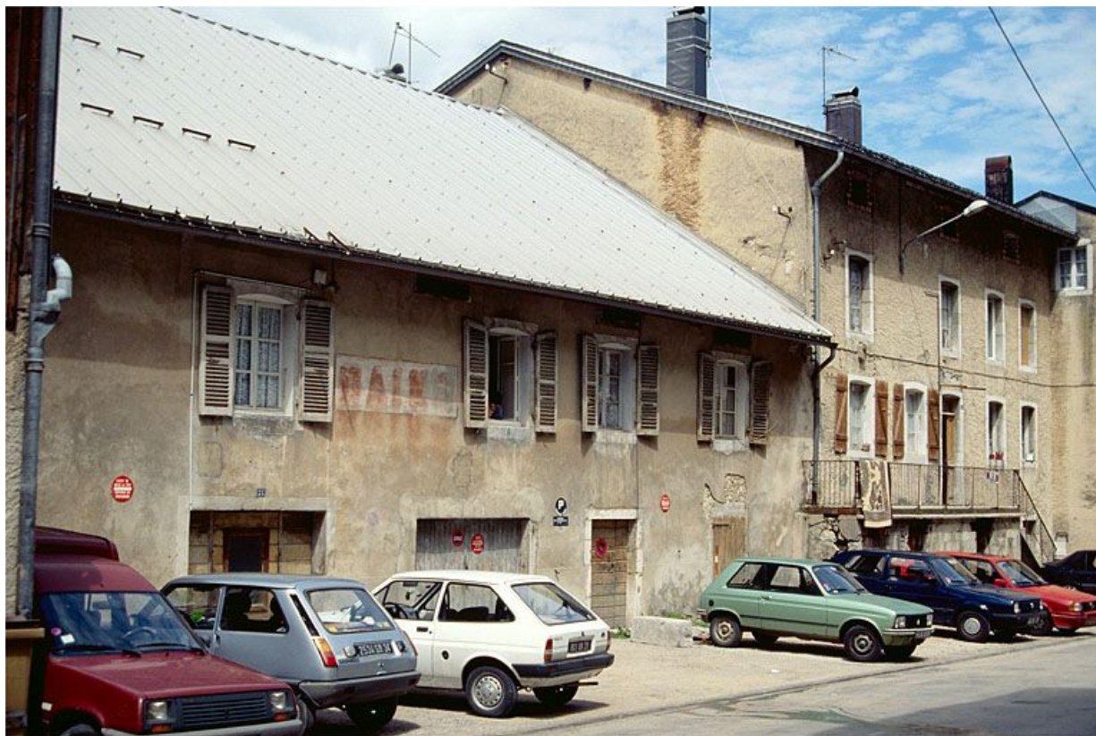
Façade antérieure de l'ancienne tannerie, de trois quarts gauche.
