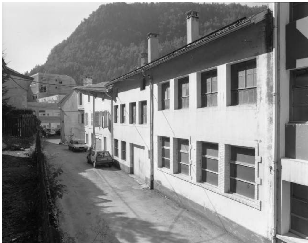
Façade antérieure des ateliers de fabrication, de trois quarts droite.
