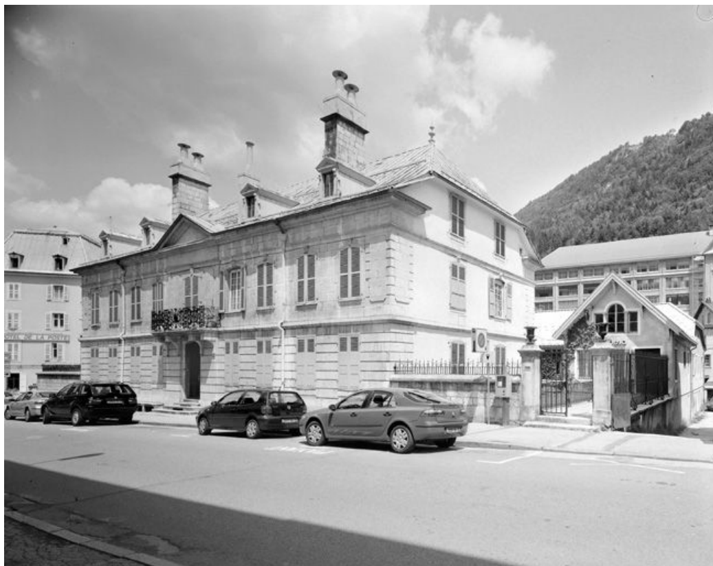
Hôtel et usine de lunetterie Les Fils d'Aimé Lamy ou Fidela (167 et 167 bis rue de la République). 39, Morez, 167, 167 bis rue de la République
