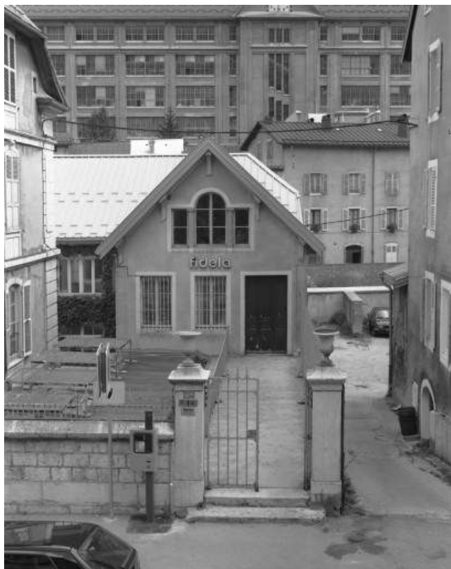
Façade antérieure de l'usine.
