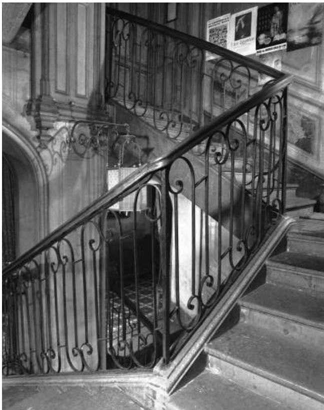
Logement patronal : cage d'escalier depuis le premier repos. 39, Morez, 167, 167 bis rue de la République
