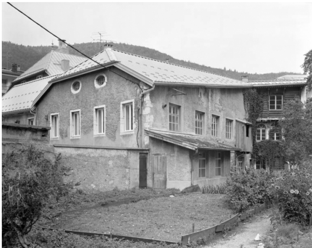
Façades latérale droite et postérieure de l'usine.
