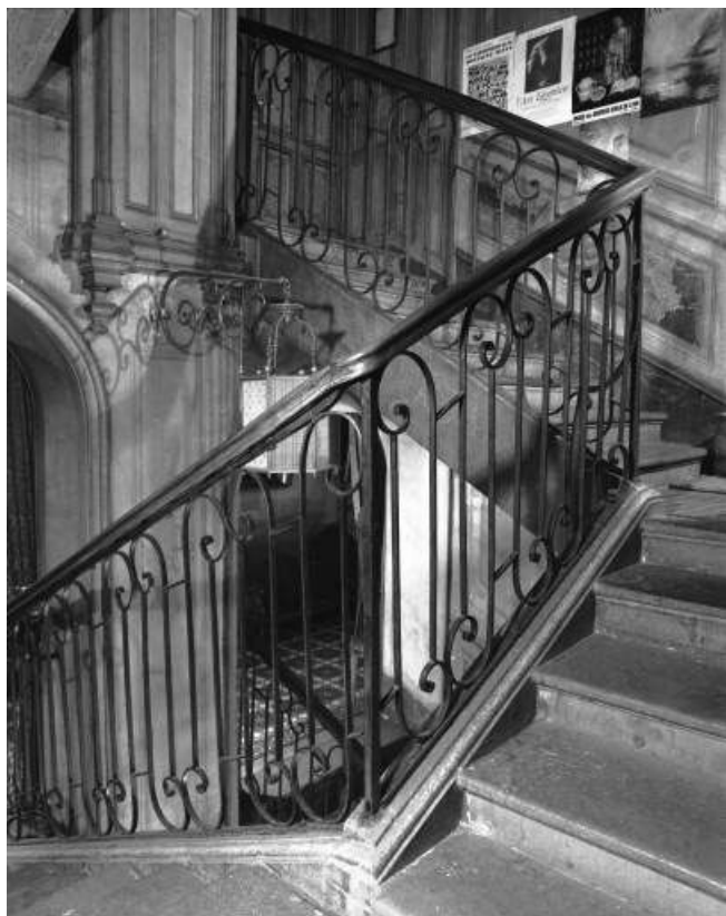
Logement patronal : cage d'escalier depuis le premier repos.
