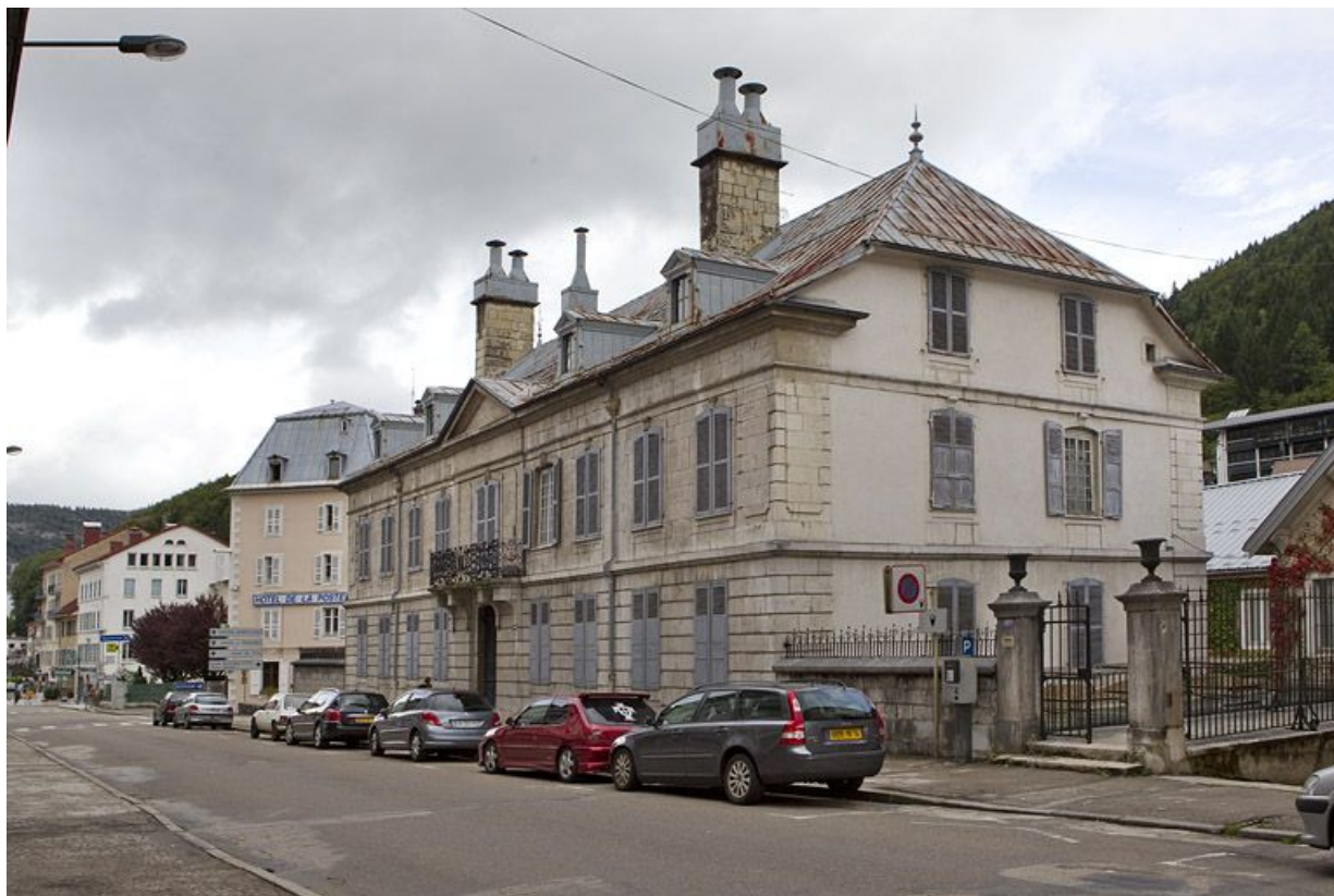
Façade du logement patronal, sur la rue. 39, Morez, 167, 167 bis rue de la République
