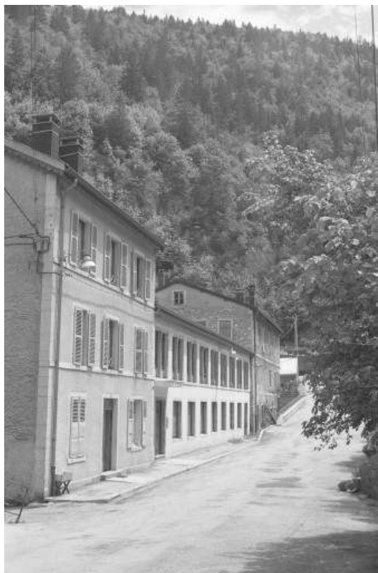
Façade antérieure des bâtiments, de trois quarts gauche.
