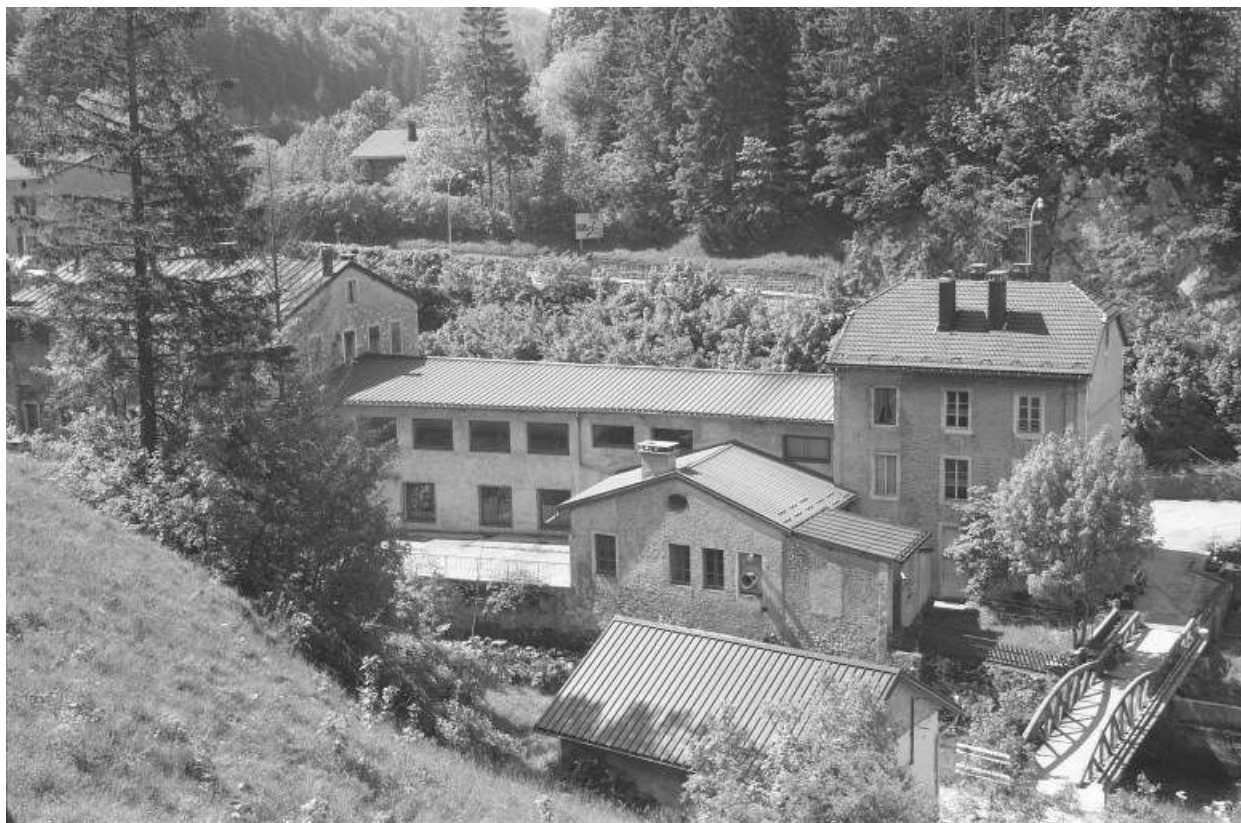
Façade postérieure des bâtiments, de trois quarts droite.
