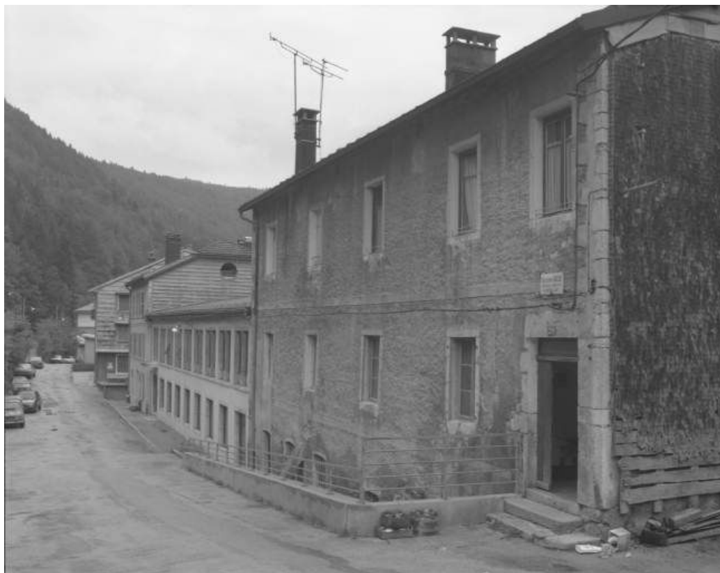
Façade antérieure des bâtiments, de trois quarts droite.
