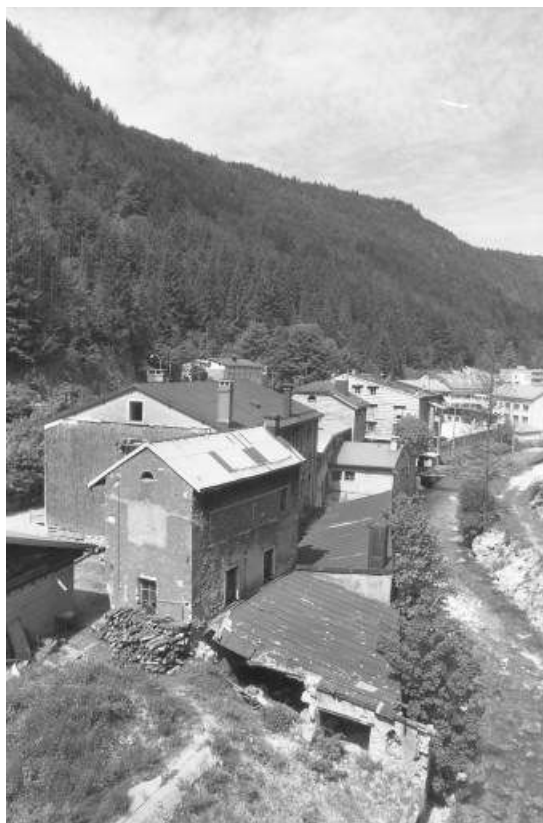
Vue d'ensemble depuis l'est (amont).
