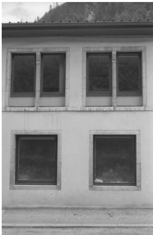
Fenêtres de l'atelier de fabrication des années 1850.
