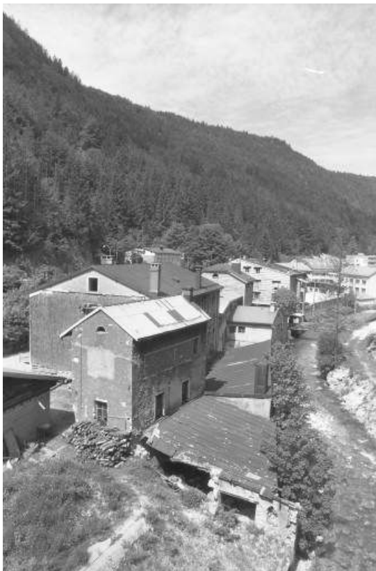
Vue d'ensemble depuis l'est (amont).
