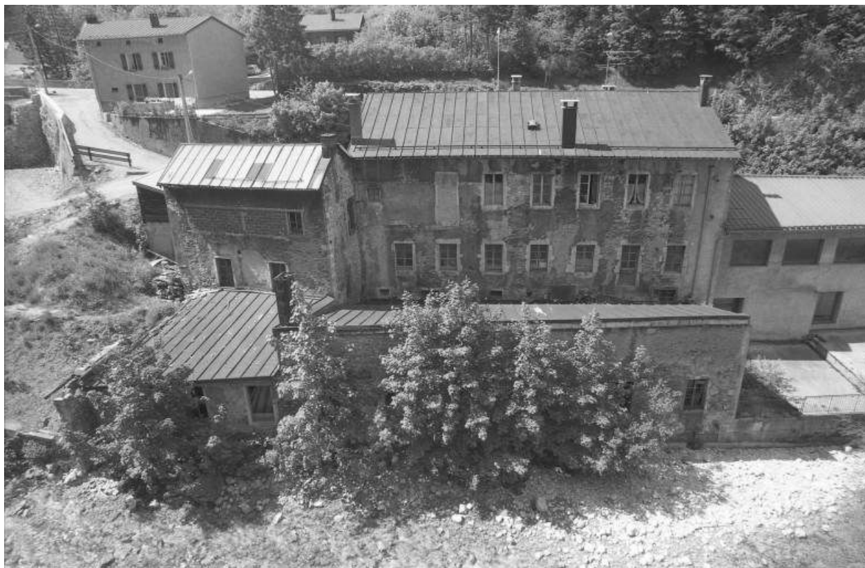
Façade postérieure des bâtiments, de trois quarts gauche.
