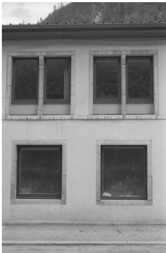
Fenêtres de l'atelier de fabrication des années 1850.
