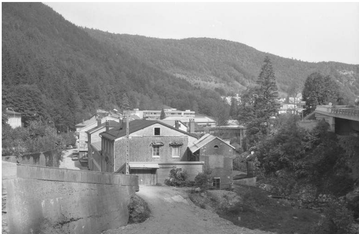
Vue d'ensemble depuis le sud (amont).
