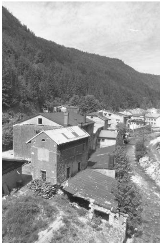
Vue d'ensemble depuis l'est (amont).
