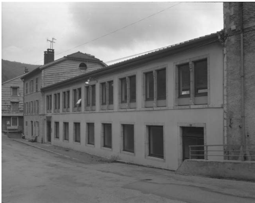
Immeuble aval et atelier de fabrication des années 1850.
