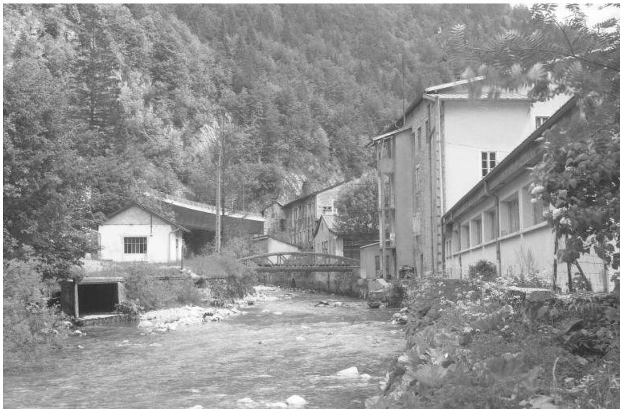
Vue d'ensemble depuis le nord-ouest (aval).
