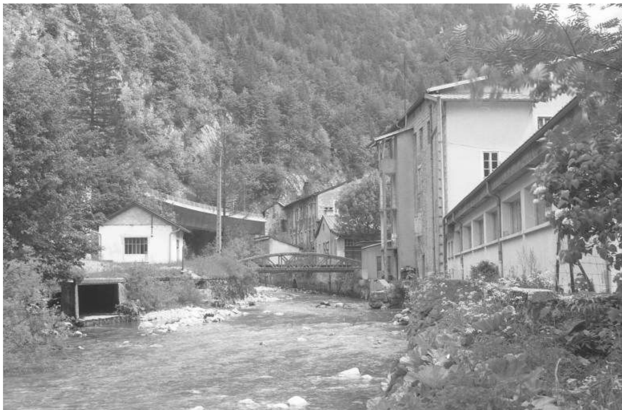
Vue d'ensemble depuis le nord-ouest (aval).
