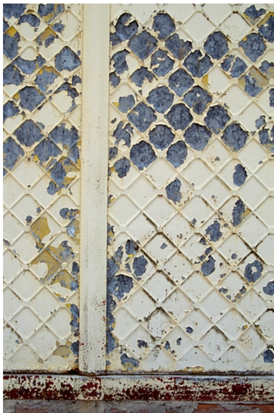
Détail d'un panneau métallique (façade latérale gauche).
