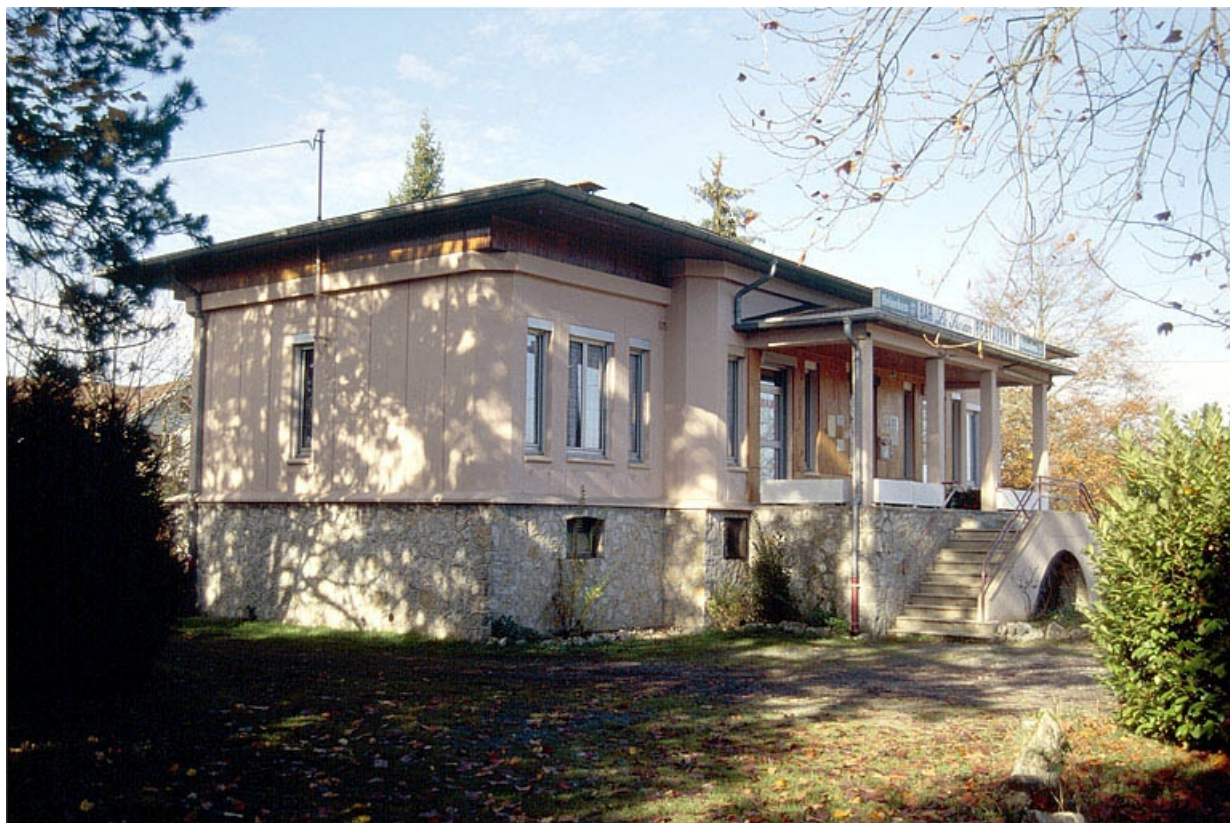
Façade antérieure vue de trois quarts gauche.
