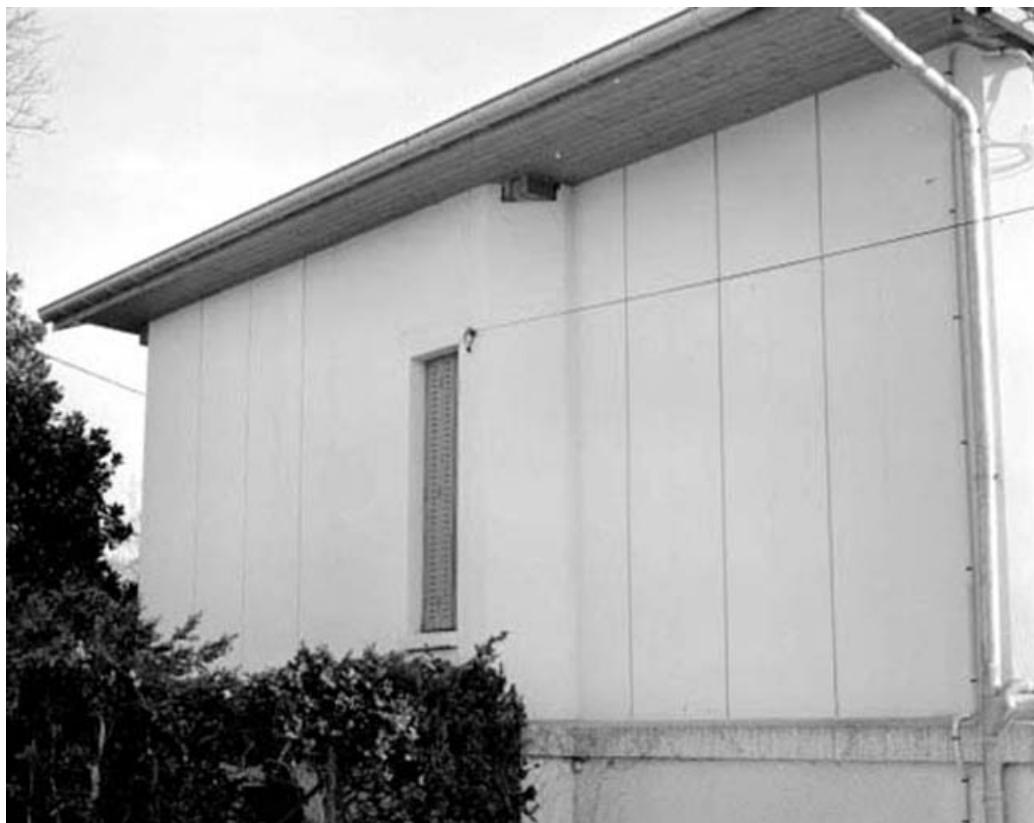
Façade latérale gauche : détail du mur.
