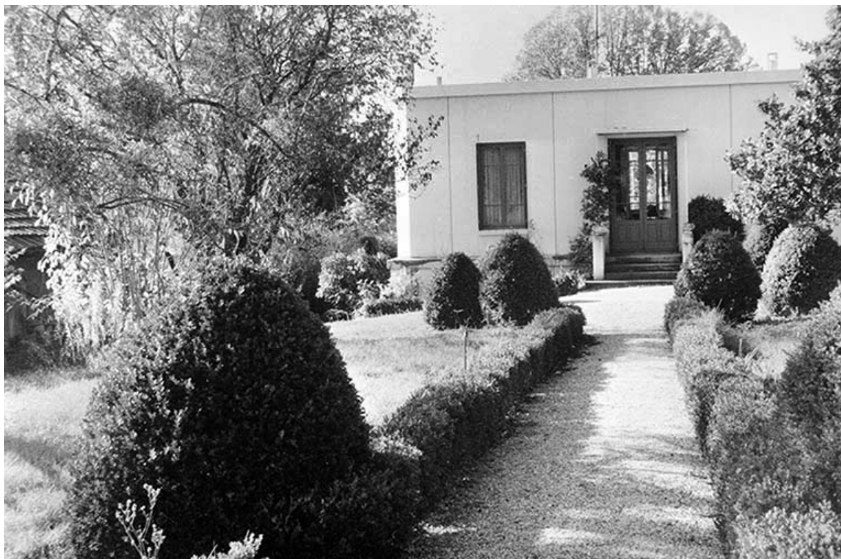
Façade postérieure avant restauration.
