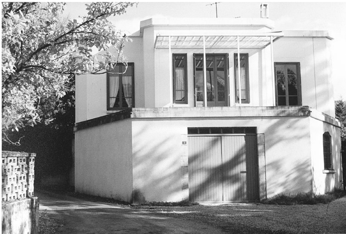
Façade antérieure avant restauration.
