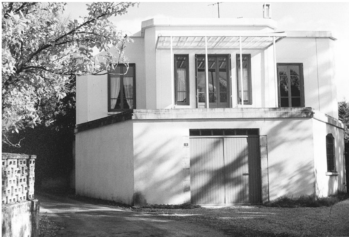
Façade antérieure avant restauration.
