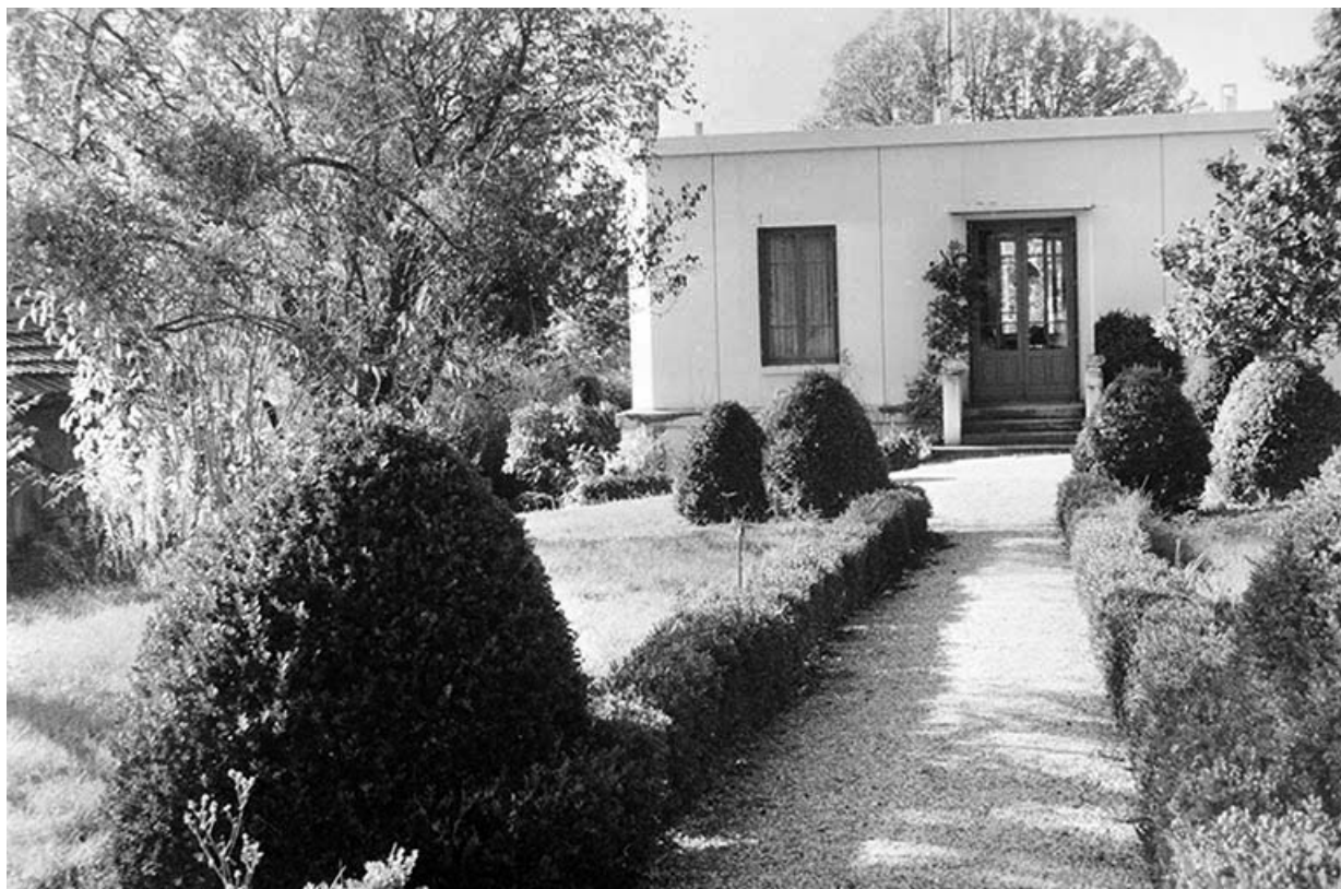
Façade postérieure avant restauration.
